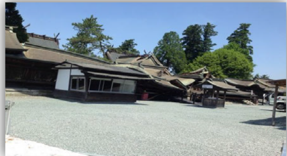
地震により倒壊した阿蘇神社
