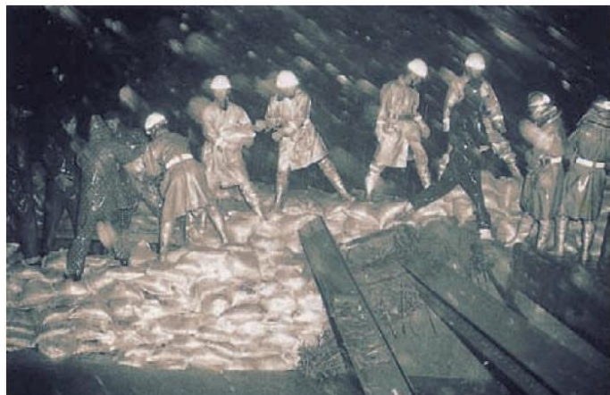
昭和57年8月洪水による浸水状況 (増水した笹笛川で真夜中に約 500人が土のう積みを展開)
