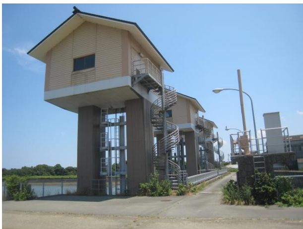
笹笛川 防潮水門 (平成12年3月完成)
