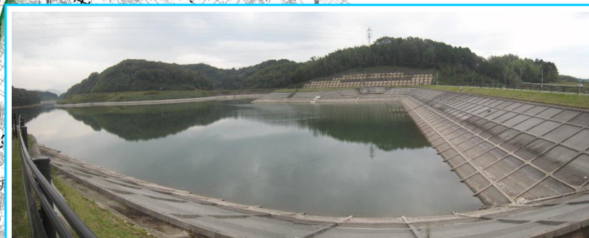
⑧【上流域】県管理区間上流端より5.3k付近 斎宮調整池
