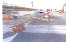
【老朽化により倒壊した信号柱(県外)】
