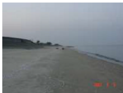
中河原乙部地区（三重県津市）
