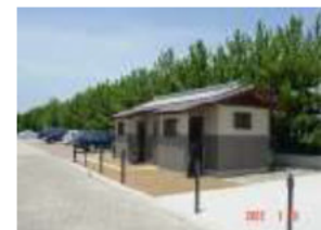
海岸堤防沿いのトイレ (三重県伊勢市)
