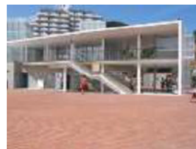
海水浴場におけるトイレ、更衣室 (愛知県南知多町)
