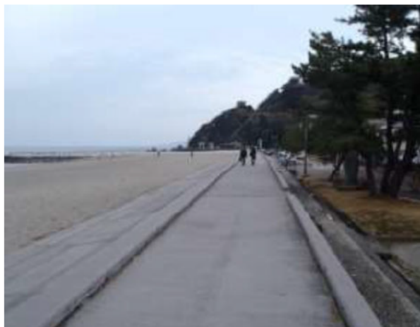
整備後の二見浦 資料：三重県
