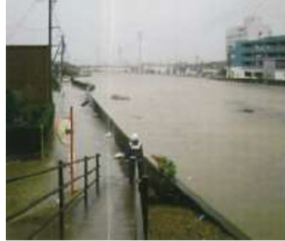
平成 21 年 台風 18 号時の二級河川 汐川での高潮遡上状況（田原市）
