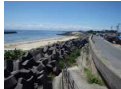
海岸堤防によるアクセスの遮断 (三重県鈴鹿市)
