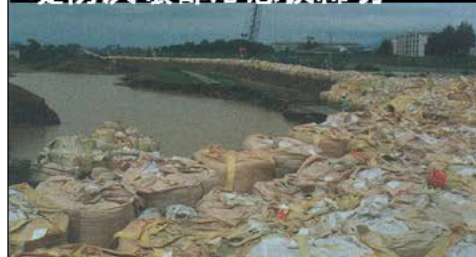
堤防決壊部応急仮締切
