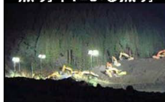
照明車による照明
