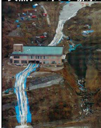
天然ダムポンプ排水
