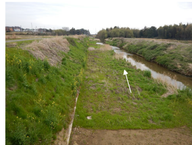
□ 下流部：堤防・護岸の整備済み区間
