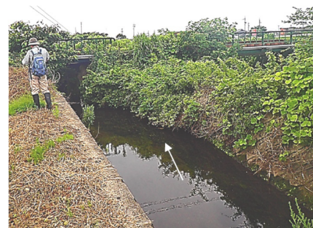
□ 上流部：JR関西本線横過部の状況
