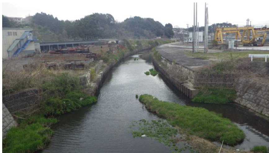
芥川 矢板護岸施工区間
