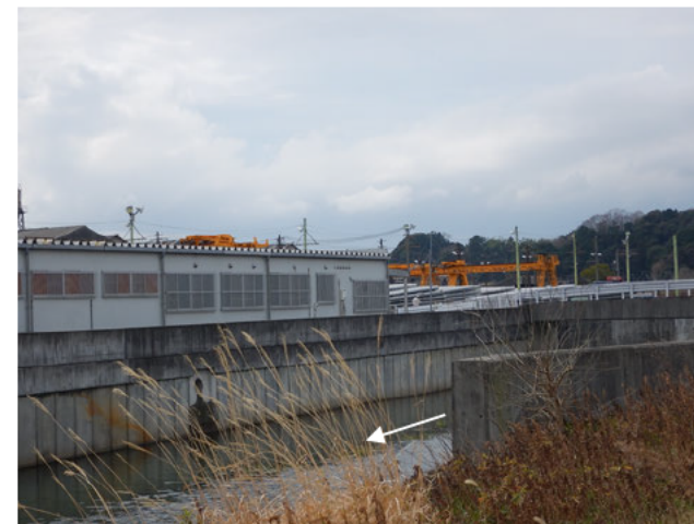
□ 下流部：PC壁体による改修状況
