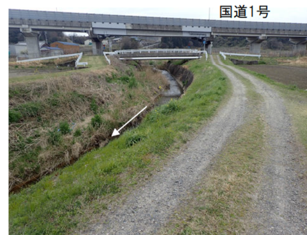
□ 上流部：未改修区間
