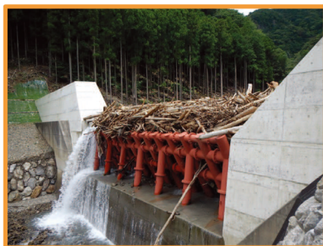
事例1 治山施設に異常に堆積した流木
