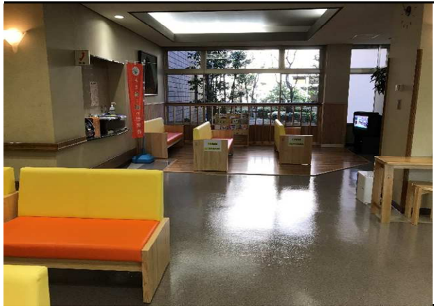
写真2 複合フローリング張り設置状況
