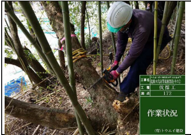
写真8 危険木伐倒状況
