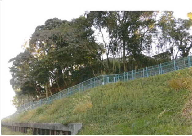
写真1 通学路階段の法面 前
