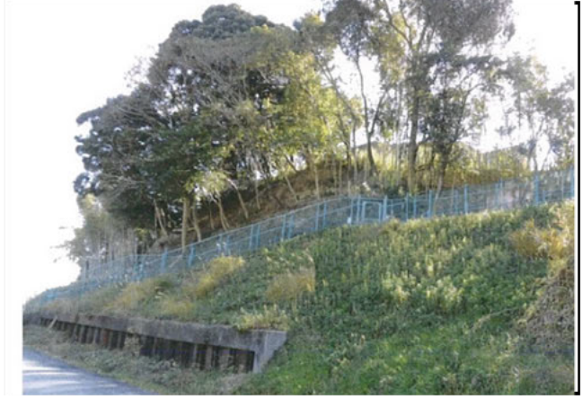
写真2 通学路階段の法面 後
