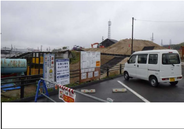
写真1 工事中看板(みえ森と緑の県民税市町交付金活用PR)
