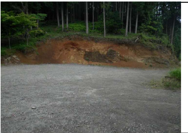
写真3 工事前 駐車場
