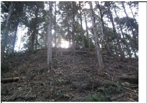
写真4 白木町花ノ木谷地区(着工後)
