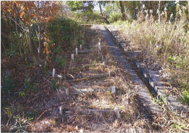
写真1 遊歩道 整備前
