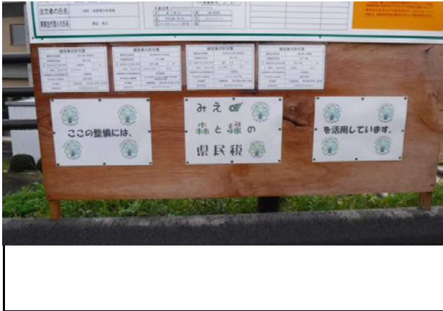
写真2 工事中看板(みえ森と緑の県民税市町交付金活用PR)
