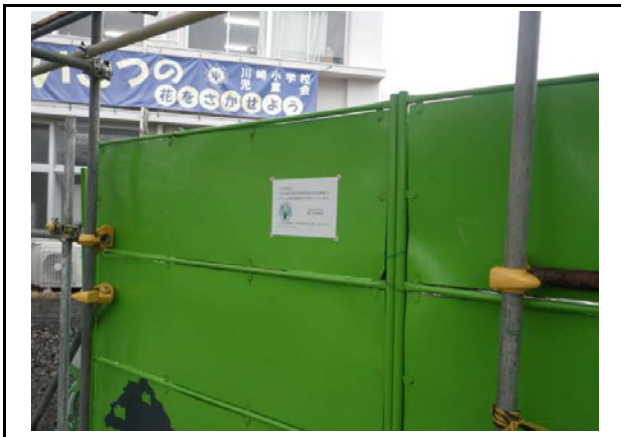
写真3 工事現場仮囲いへの税事業明示
