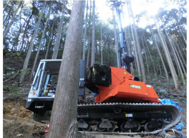
高性能林業機械（タワーヤーダ）の導入（大台町）
