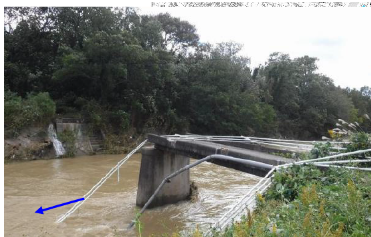
写真①：外城田川の増水で落橋した無名橋（大野橋上流）
