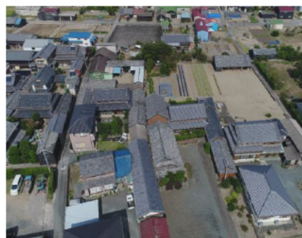
ドローンによる被害状況偵察
