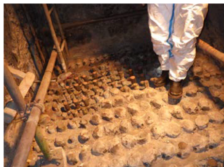
ボイラー点検の様子
