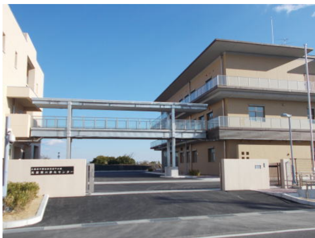
志登茂川浄化センター
