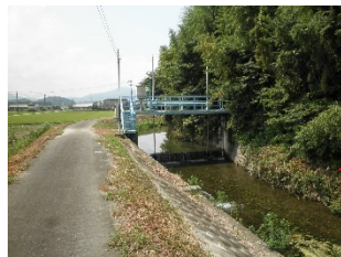
小規模な取水堰
