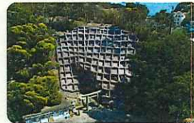
山腹法面の復旧
