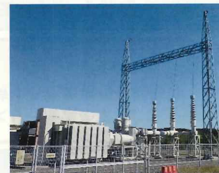
撤去予定の施設 (変電所)
