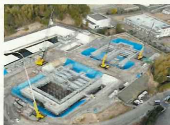
築造工事施工中の施設 （大里浄水場）
