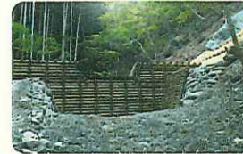
治山ダムの整備
