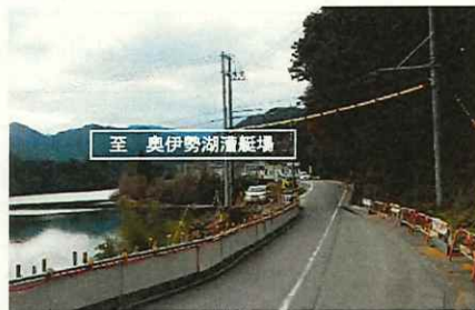
県道大台宮川線 弥起井(大台町)
