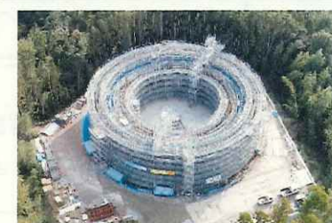
築造工事施工中の施設 （垂坂配水池）
