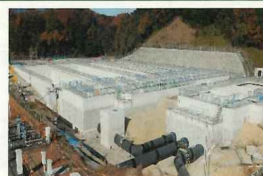
耐震化工事施工中の施設 （山村浄水場）
