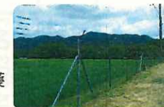
侵入防止柵の整備
