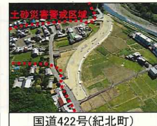
国道422号(紀北町)
