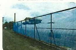
防風対策ネットの設置
