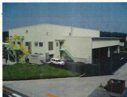
撤去予定の施設 (RDF貯蔵施設)
