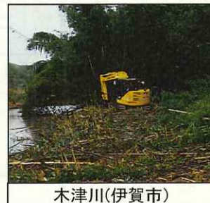
木津川(伊賀市)
