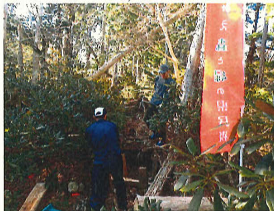
自然観察ツアー参加者による施設整備 階段設置（作業状況）
