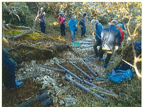
自然観察ツアー参加者による施設整備 階段補修（作業状況）
