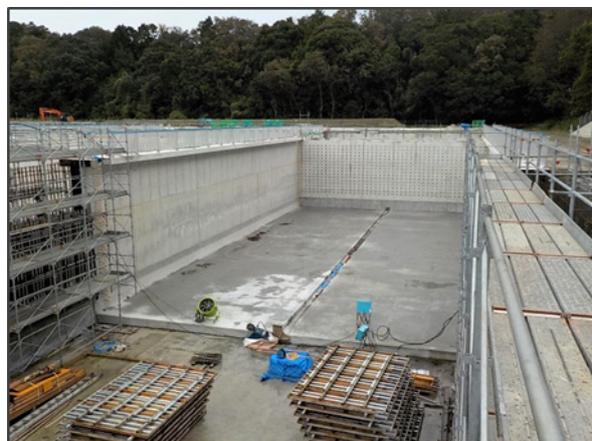
山村浄水場耐震化工事施工状況（沈殿池築造）
