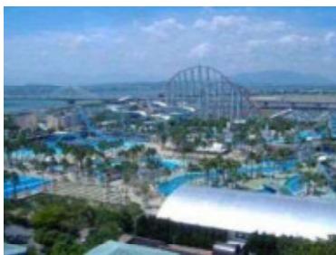
伊勢湾岸道路とレジャー施設 (桑名市)
