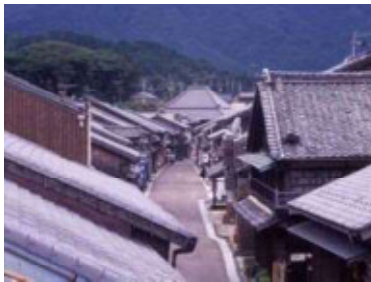
東海道関宿・伝統的建造物群保 存地区(亀山市)
