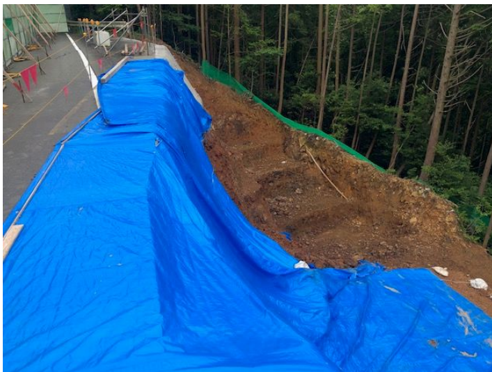
路側掘削状況
