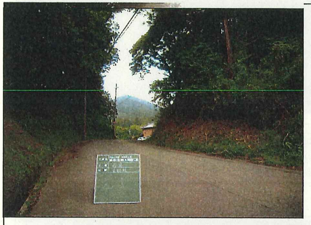
写真2 完成 E地区 No. 3 市道沓掛線
