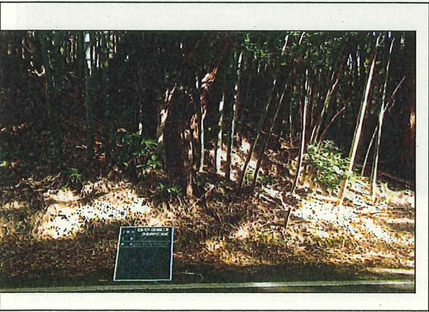
写真5 着工前 C地区 No. 14 市道西町落針線
