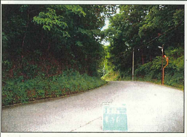
写真3 着工前 E地区 No. 3 市道沓掛線
