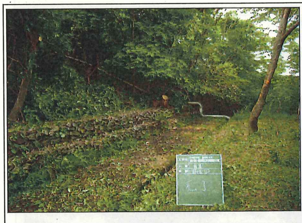
写真12 完成 E地区 No. 2 関ヶ丘緑地
