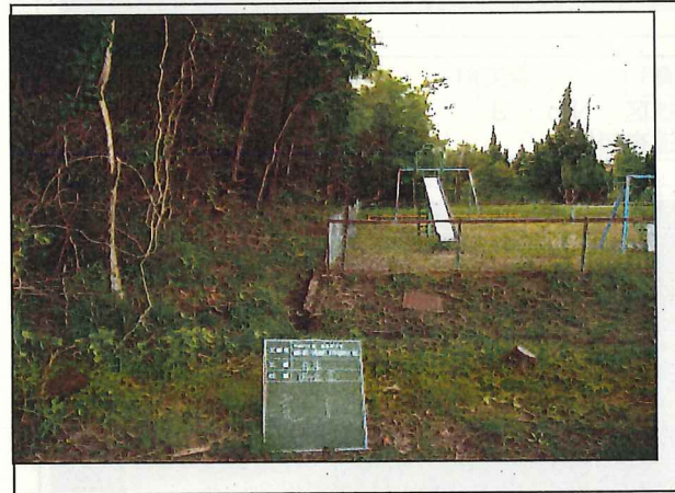
写真10 完成 E地区 No. 2 関ヶ丘緑地
