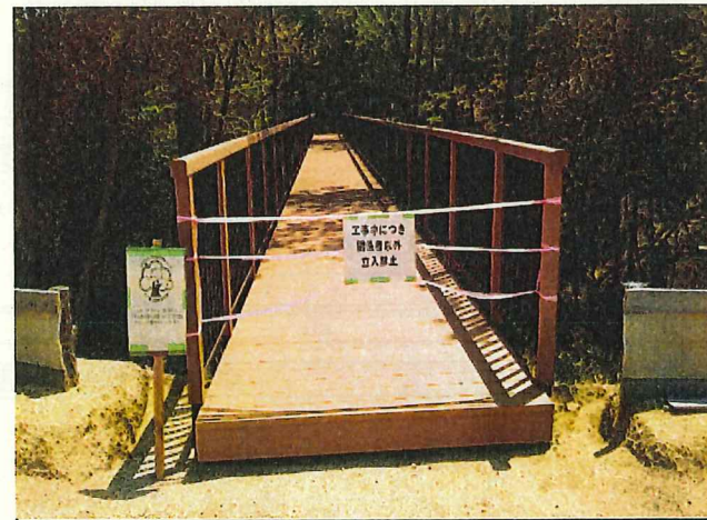
写真6 施工後③ (完成検査終了後 看板にてPR)
