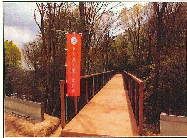
写真4 施工後① (のぼり旗にてPR)
