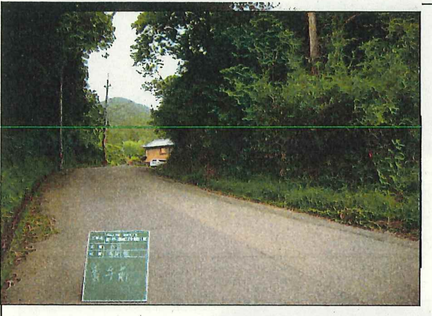
写真1 着工前 E地区 No. 3 市道沓掛線
