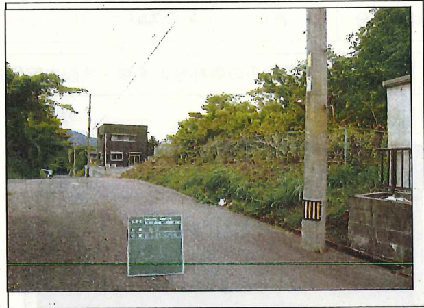
写真8 完成 E地区 No. 9 関ヶ丘緑地
