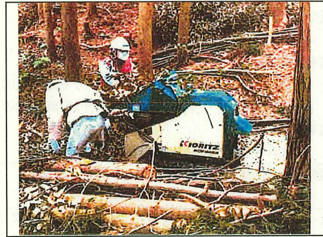
写真10 施工中 (四日市自然保護推進委員会)
