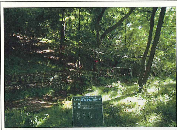
写真11 着工前 E地区 No. 2 関ヶ丘緑地
