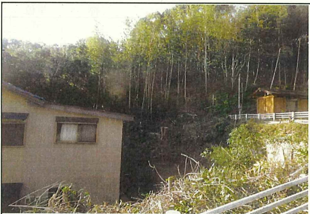
写真4 自然公園周辺危険木伐採(施行後)
