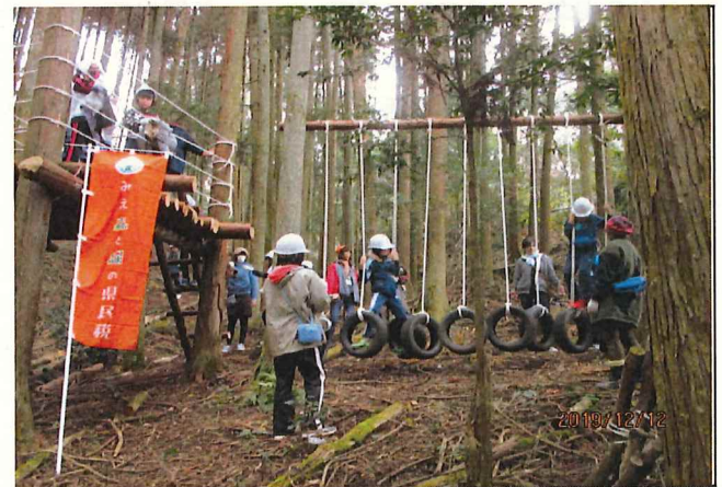
写真6 整備後の学校林
