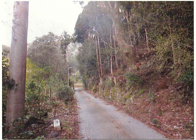
写真8 永会木屋地内県道（危険木伐採後）
