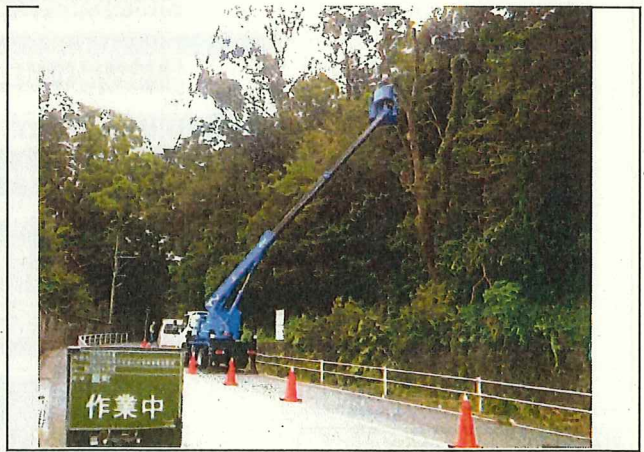
写真6 森林整備(支障木伐採 作業状況)
