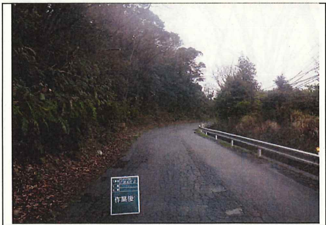
写真9 作業後(池上町)
