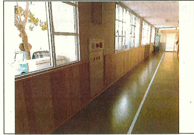
写真12 大河内小学校廊下腰壁木質化（完成）
