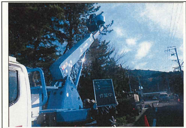
写真11 作業中(鳥羽一丁目)
