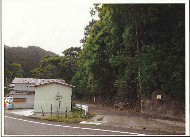
写真8 島勝浦地区【実施後】
