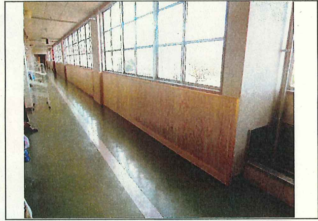
写真10 伊勢寺小学校廊下腰壁木質化（完成）
