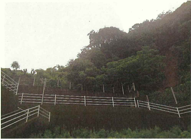
写真1 錦釜戸地区避難所避難路（危険木伐採前）
