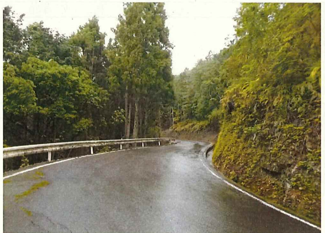
写真6 林道一の水線（整備後）⑥
