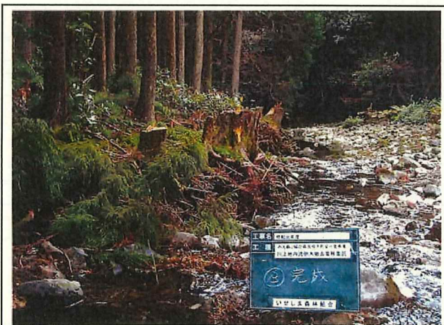
写真4 川上地区② 施行後
