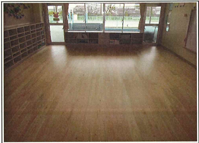
写真1 田丸保育所（うさぎ室1）床改修工事
