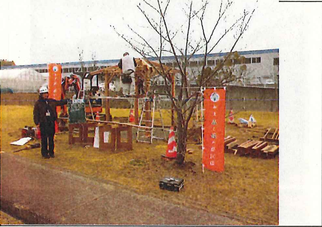
写真7 施工中 啓発のぼり設置状況
