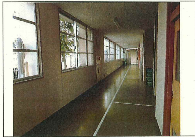
写真11 大河内小学校廊下腰壁木質化（着手前）
