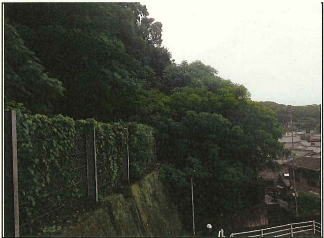
写真3 錦釜戸地区避難所避難路（危険木伐採前）
