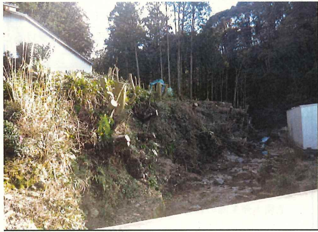
写真4 金輪大谷地内（危険木伐採撤去後）
