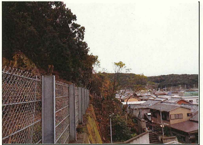
写真4 錦釜戸地区避難所避難路（危険木伐採後）
