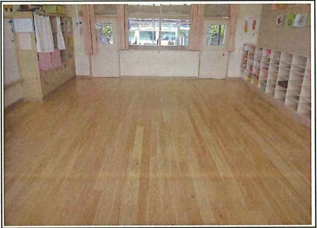
写真2 田丸保育所（うさぎ室1）床改修工事
