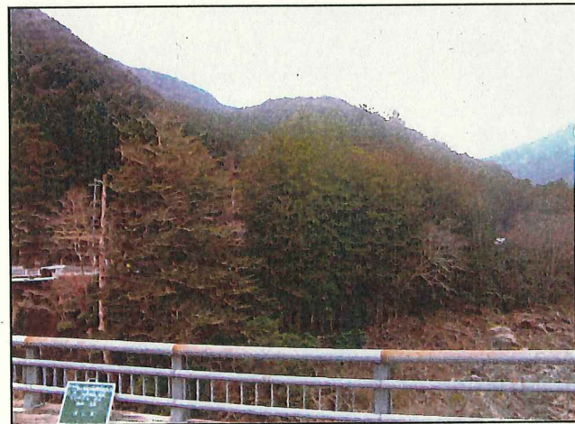
写真3 伐採箇所（施工前状況②）
