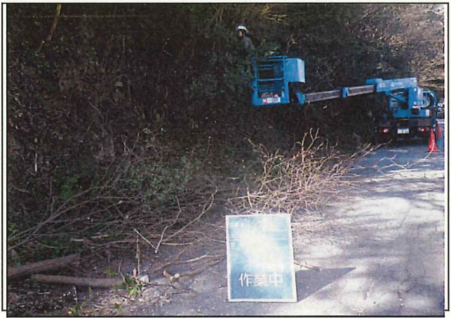
写真8 作業中(池上町)
