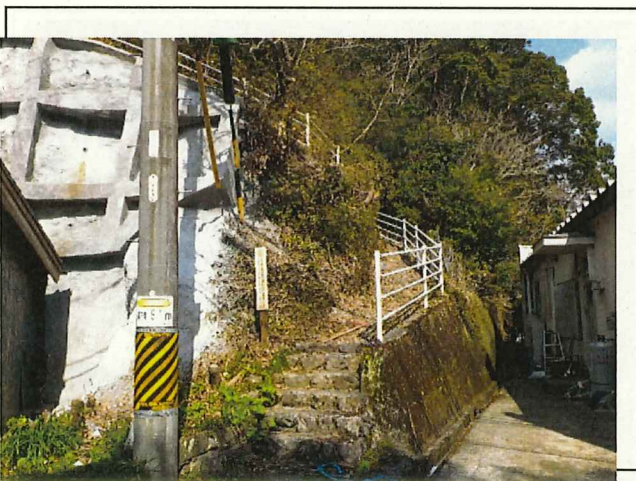
写真6 中新田地区【実施後】
