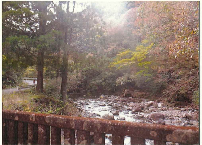
写真10 大内山池ノ谷越地内（危険木伐採撤去後）
