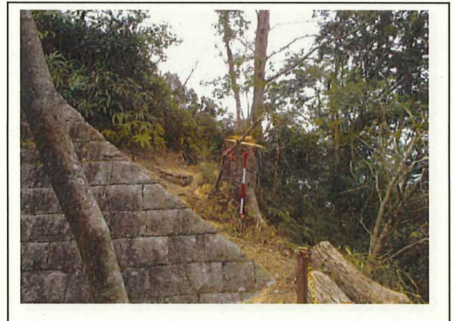
写真4 危険木伐採② 施工後
