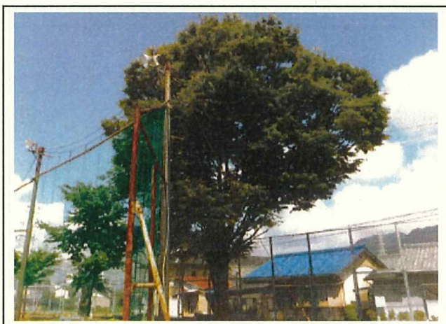
写真5 危険木伐採、剪定（尾鷲中学校）施工前
