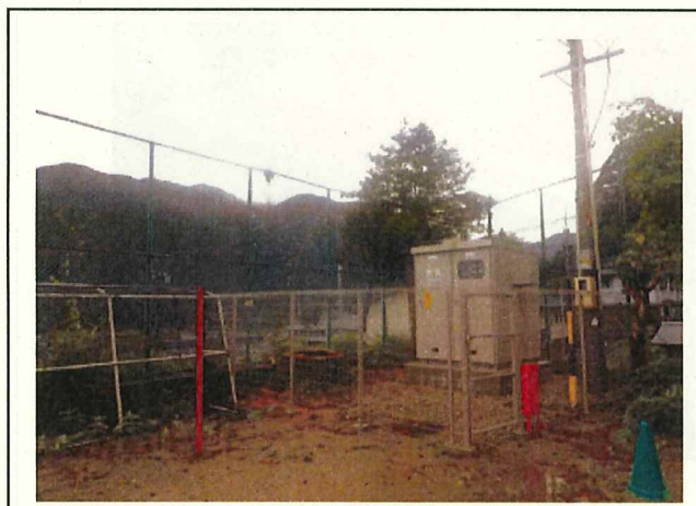
写真4 危険木伐採、剪定（賀田小学校）施工後
