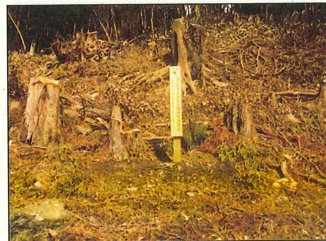
写真5 事業周知看板の設置
