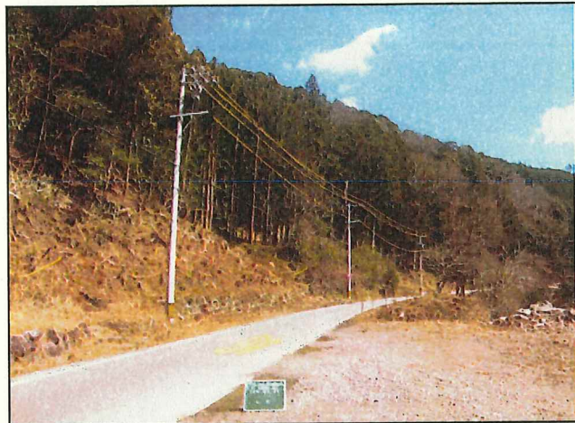
写真2 伐採箇所（施工後状況①）
