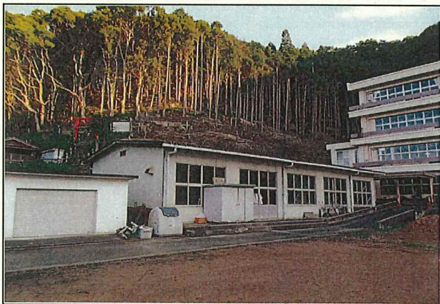
写真2 矢渕中学校裏山危険木伐採(施行後)
