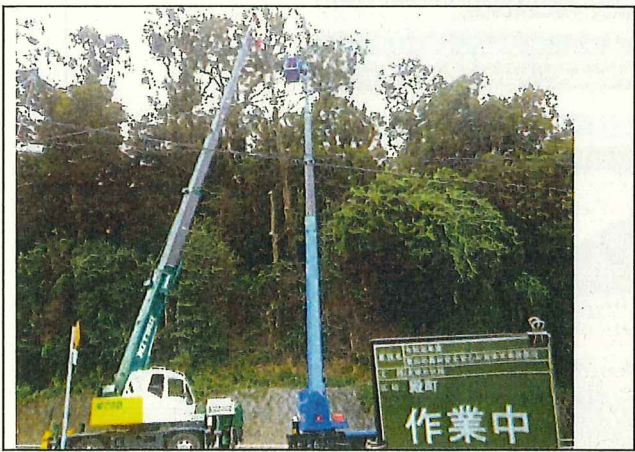
写真5 森林整備(支障木伐採 作業状況)
