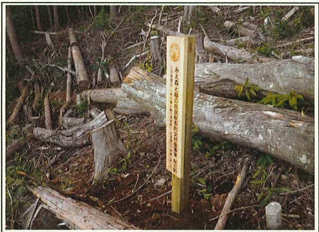
写真3 新町3区【看板設置状況】
