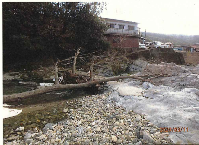
写真5 永会藤地内（危険木撤去前）
