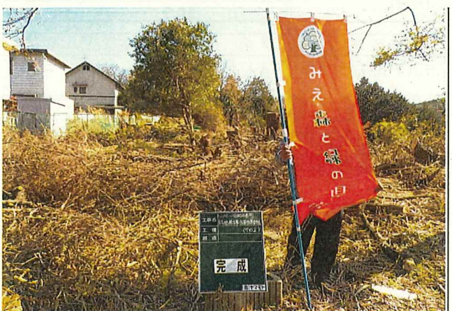
写真4 伐採作業完了【富貴ヶ丘4番町緑地】
