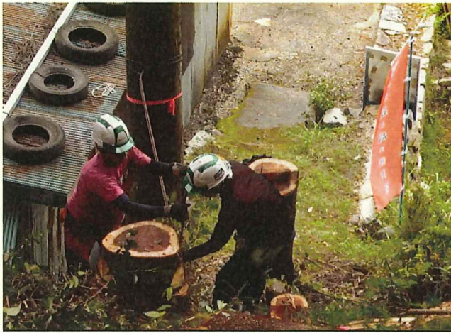
写真2 作業風景②
