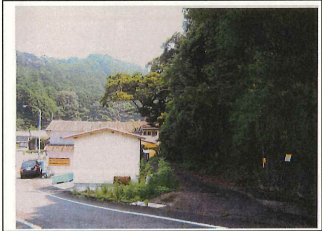
写真7 島勝浦地区【実施前】
