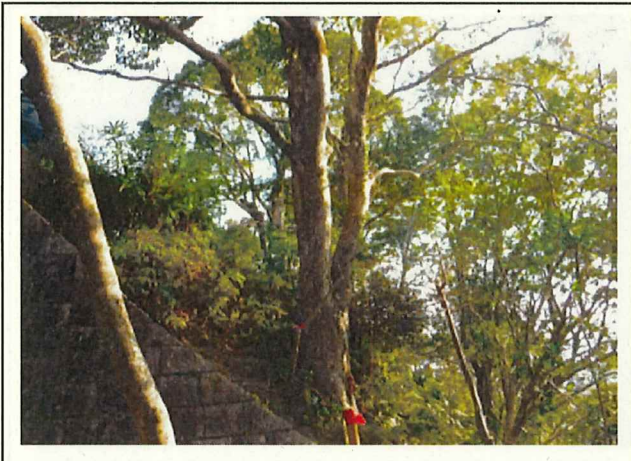
写真3 危険木伐採② 施工前
