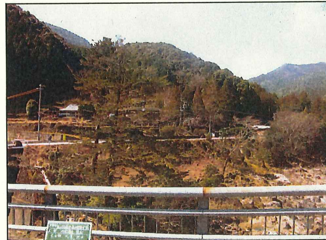
写真4 伐採箇所（施工後状況②）
