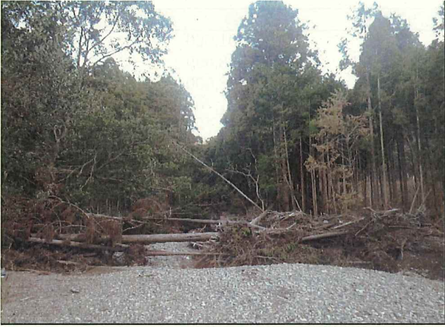
写真7 錦大岩地内（危険木伐採撤去前）
