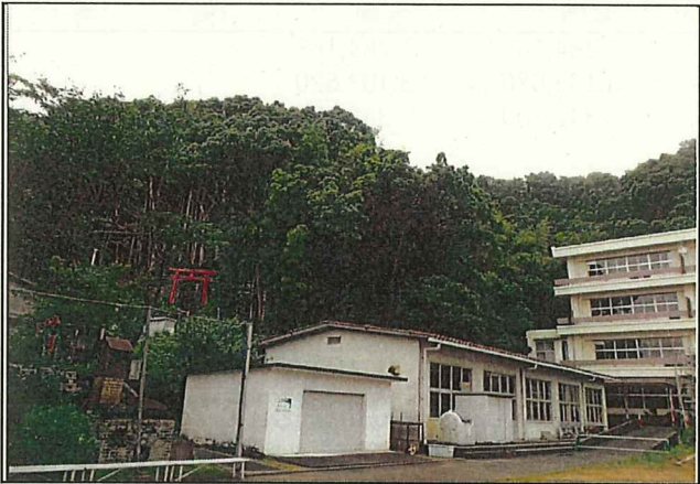
写真1 矢渕中学校裏山危険木伐採(施行前)
