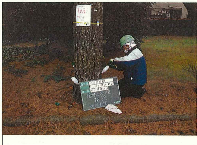
写真4 薬剤注入状況
