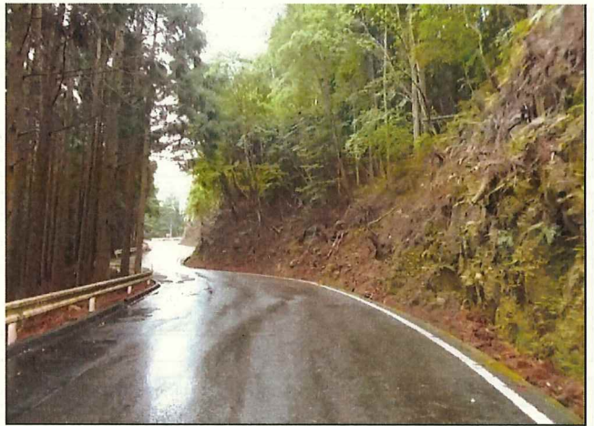
写真4 林道一の水線（整備後）④
