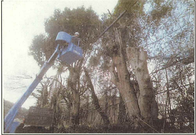
写真2 作業中(加茂中学校)
