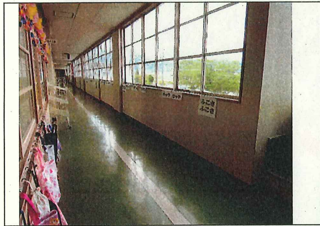
写真9 伊勢寺小学校廊下腰壁木質化（着手前）
