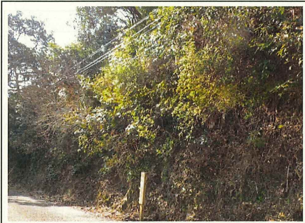
写真9 島勝浦地区【看板設置状況】
