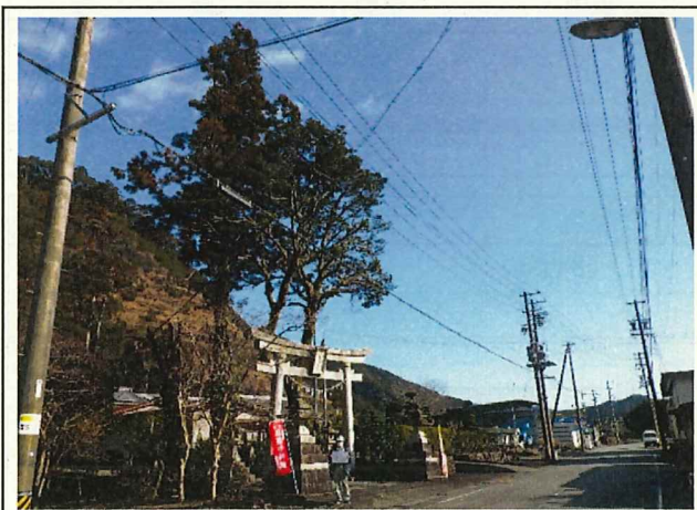
写真11 中里地区【実施後】
