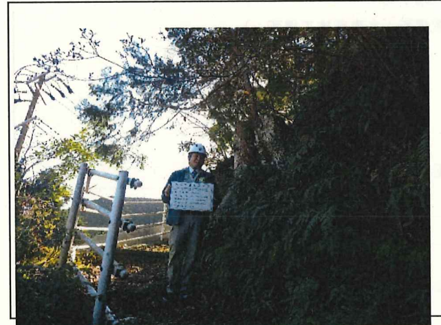
写真5 中新田地区【実施後】
