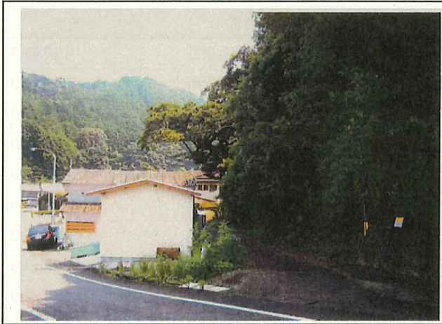
写真7 島勝浦地区【実施前】
