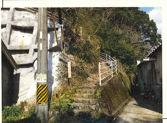
写真6 中新田地区【実施後】
