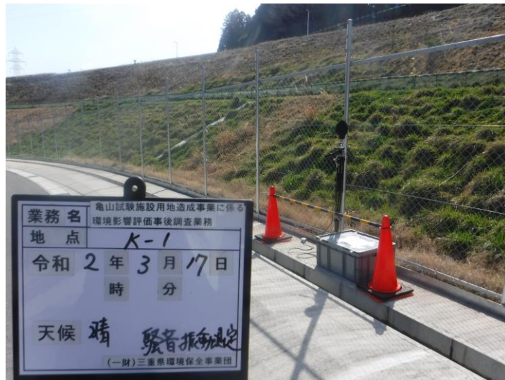
写真 1-4 騒音・振動調査状況 (K-1 : 令和2年3月17日)
