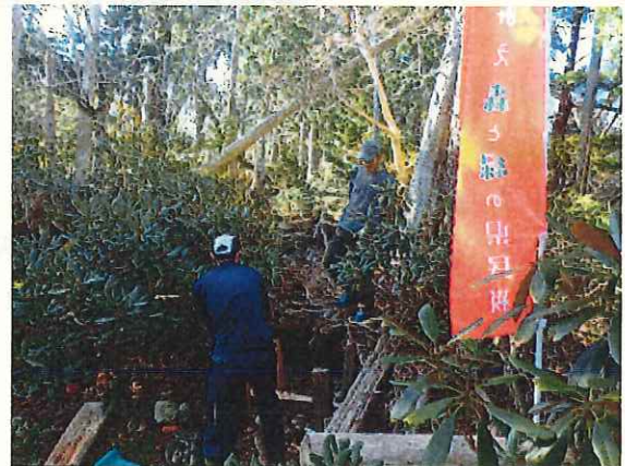
自然観察ツアーボランティア整備 階段設置（作業状況）
