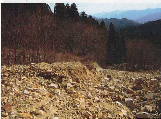
事例2 松阪市飯高町(大崩) 整備前
