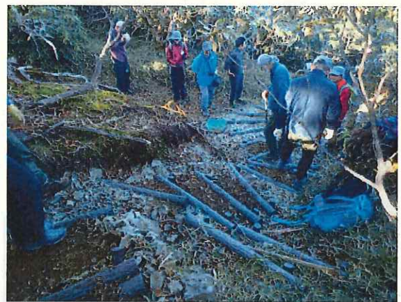
自然観察ツアーボランティア整備 階段補修（作業状況）
