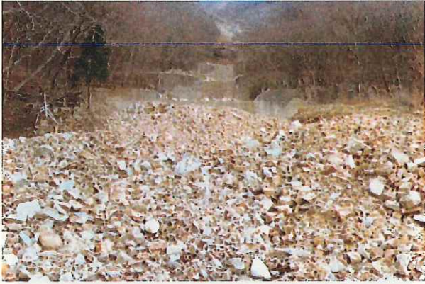
事例2 松阪市飯高町(大崩) 整備前
