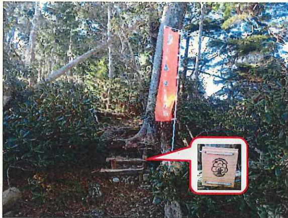
自然観察ツアーボランティア整備 階段設置（整備後）
