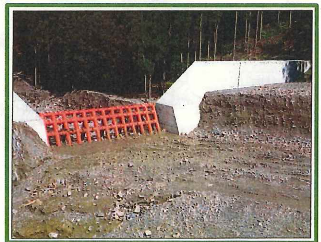
流木撤去後（大台町）
