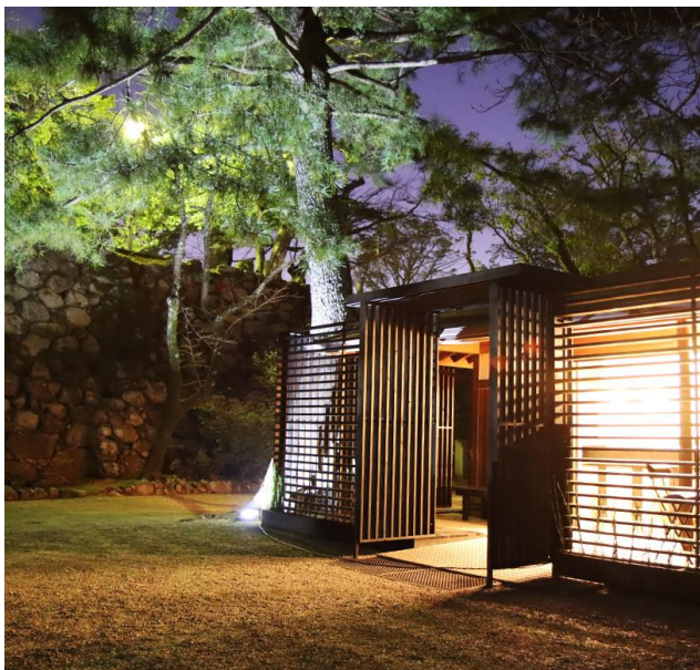
飯高産木材の格子で囲まれた施設外観
