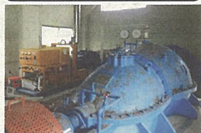
老朽化した排水機
