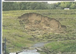
ため池の法面崩壊
