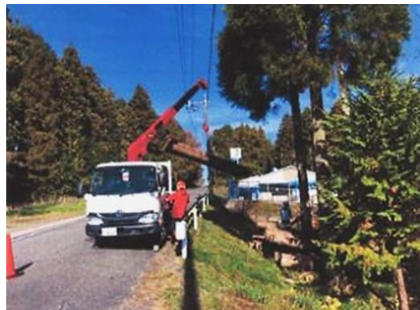
危険木の除去事業（いなべ市）
