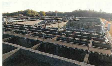
耐震化工事予定の施設 (伊坂浄水場)
