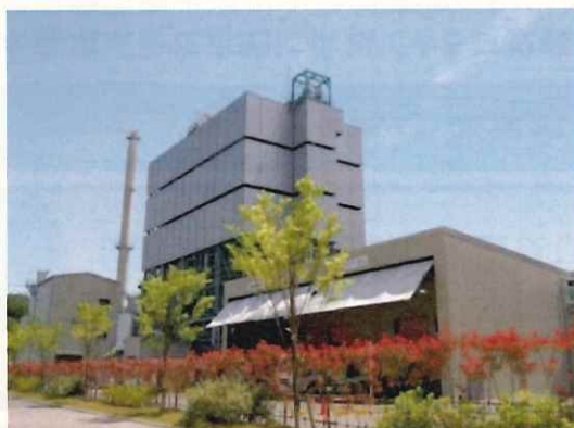
撤去予定の施設 (RDF焼却・発電施設)
