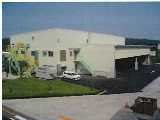
撤去予定の施設 (RDF貯蔵施設)
