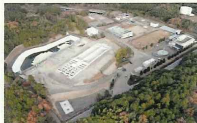
築造工事施工中の施設 (大里浄水場)
