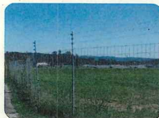
侵入防止柵の整備
