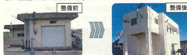
排水機場の耐震対策
