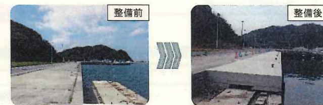
耐震岸壁の整備
