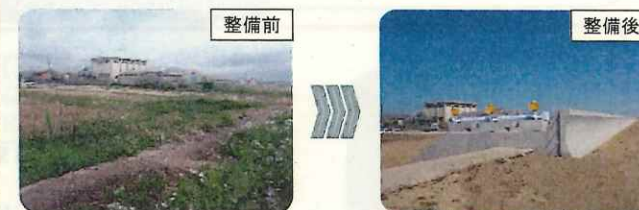
海岸堤防の耐震対策
