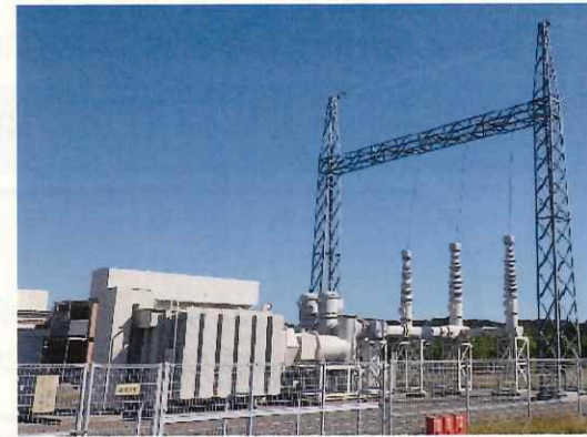
撤去予定の施設 (変電所)
