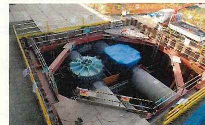
制水弁取替工事の施工例
