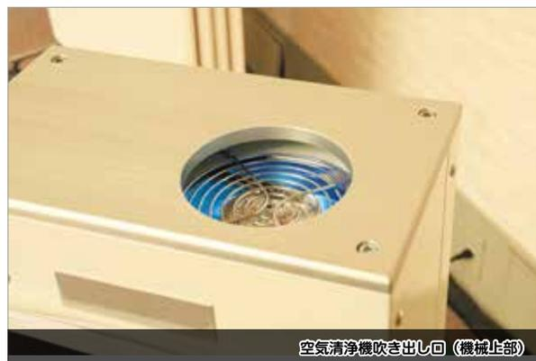
空気清浄機吹き出し回 (機械上部)
