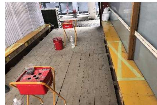
テントと併せて送風機やスポットクーラー、ドライミスト発生装置等を設置
