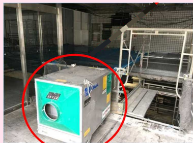
集塵機を設置し室内の換気を実施
