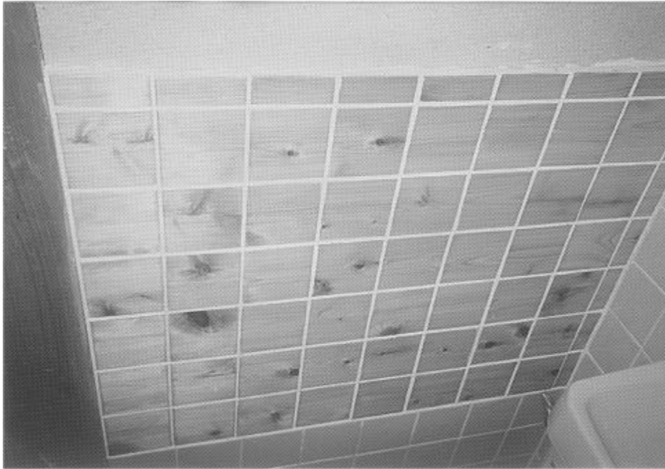
写真 - 2 現地実用化試験の状況
