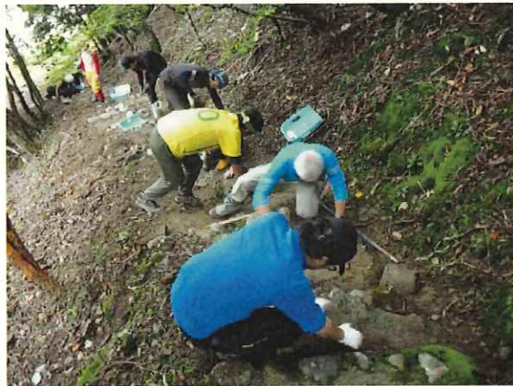
自然観察ツアー&ボランティア整備 参加者による歩道の補修作業状況
