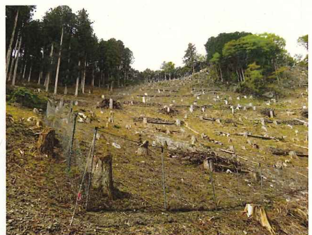
整備後点検状況
