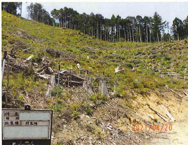
整備後点検状況
