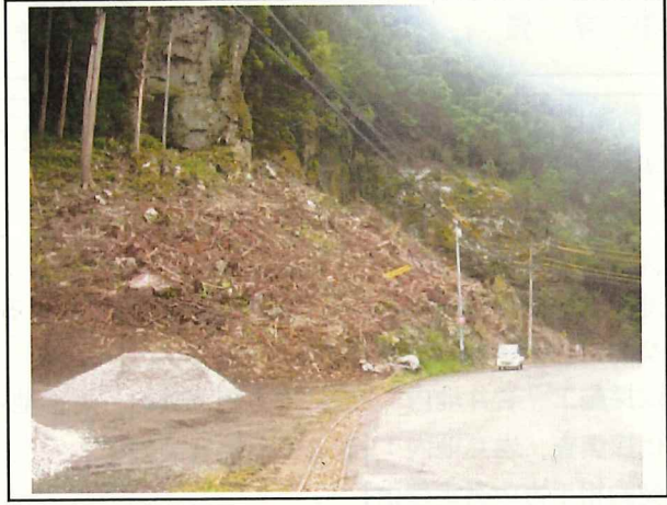
写真2 大台町岩井地内①【伐採後】
