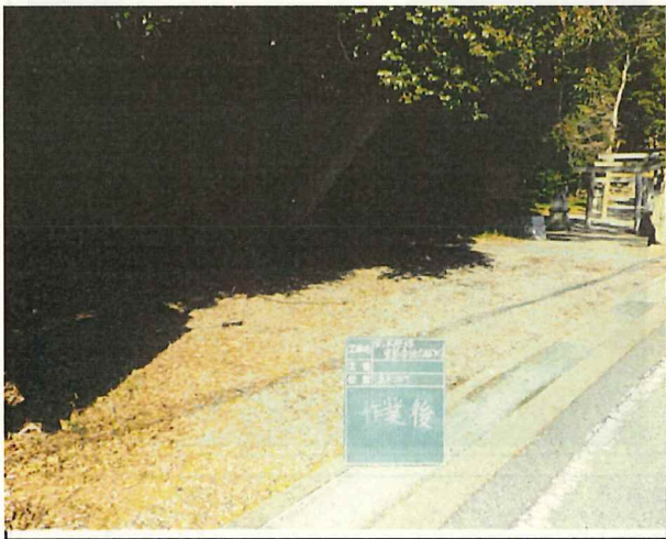
写真15 倒木処理業務委託【施行後】
