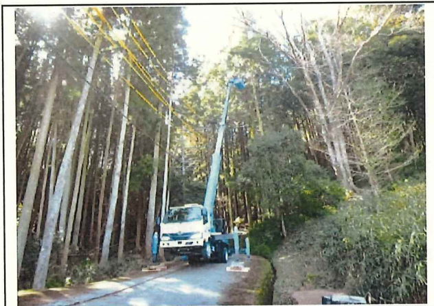
写真3 災害からライフラインを守る事前伐採事業 (美杉町八知地内 実施中)
