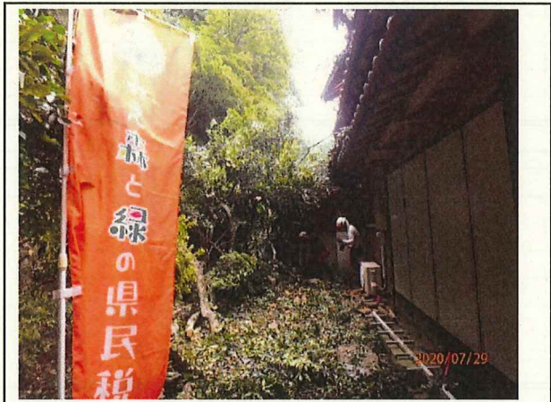
写真27 大内山向駒地区 人家裏作業中
