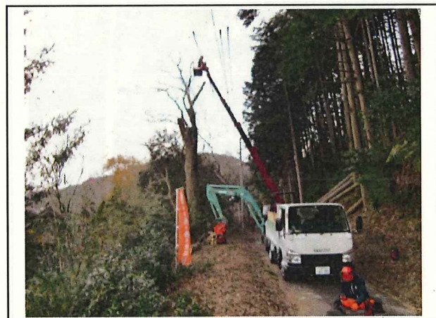
写真9 滝原河原地区 人家裏危険木作業中
