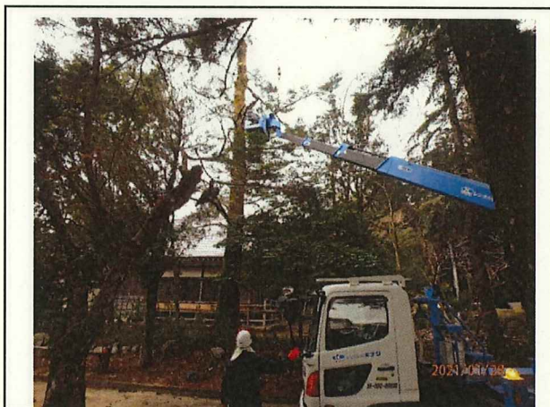
写真16 滝原頓登原地区 生活道路作業中
