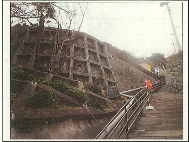
写真8 危険木伐採事業業務委託（神島地区）【施行後】
