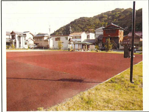
写真2 阿曾浦公園 ウッドチップ舗装 後
