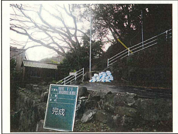
写真4 危険木伐採事業業務委託（藤之郷地区）【施行後】
