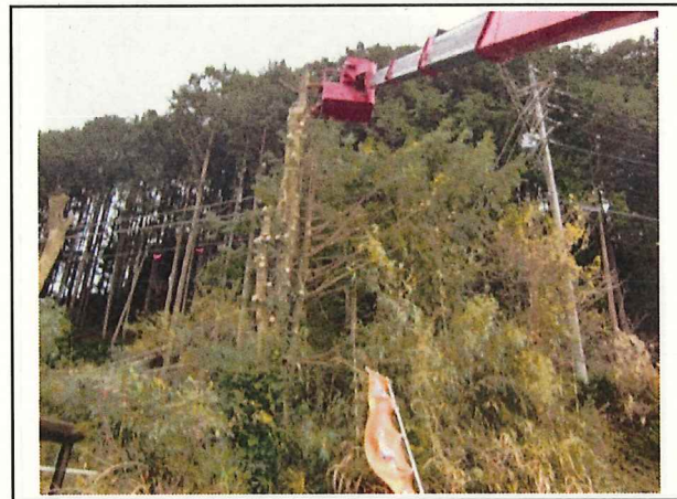
写真10 滝原河原地区 人家裏危険木作業中
