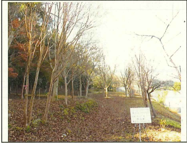
写真1 伐採、敷砂利舗装工【施工前】
