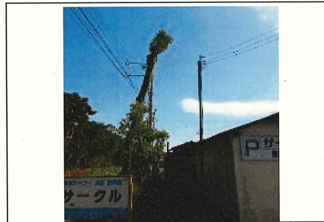
写真6 危険木伐採後
