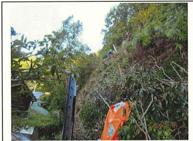
写真21 錦の場地区 人家裏作業中
