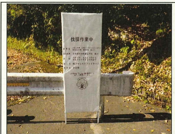
写真 9 大台町滝谷地内 工事看板設置状況
