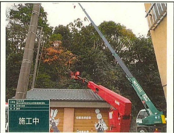
写真5 森林整備(作業状況) 松阪市殿町地内 12t級ラフタークレーン、27m級高所作業車使用
