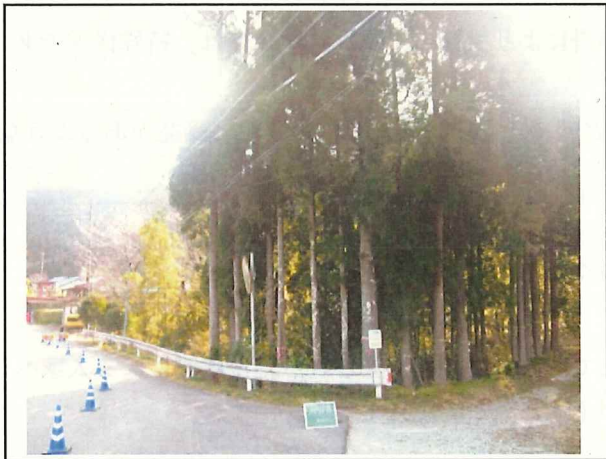
写真3 大台町清水地内危険木伐採【施工前】
