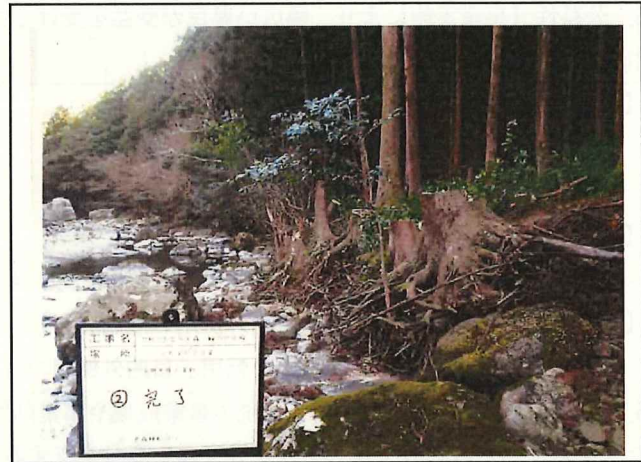
写真4 川上地区② 施行後
