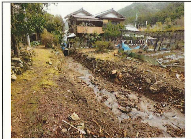
写真15 崎下崎地区 完成
