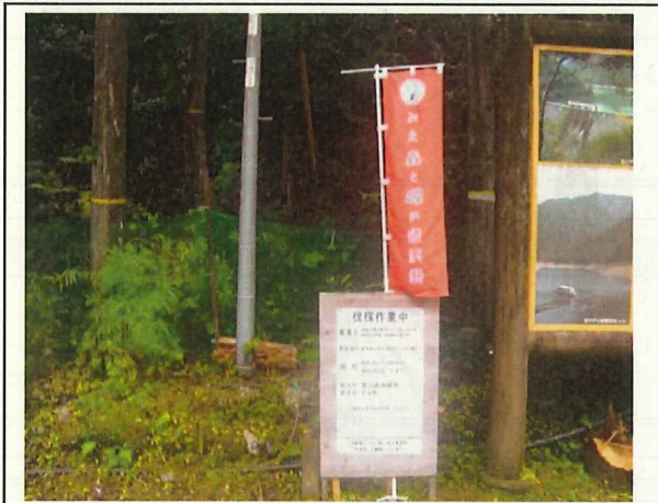
写真 7 大台町岩井地内 工事看板、のぼり掲示状況
