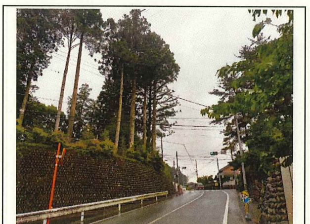
写真6 野原久保地区 生活道路完成
