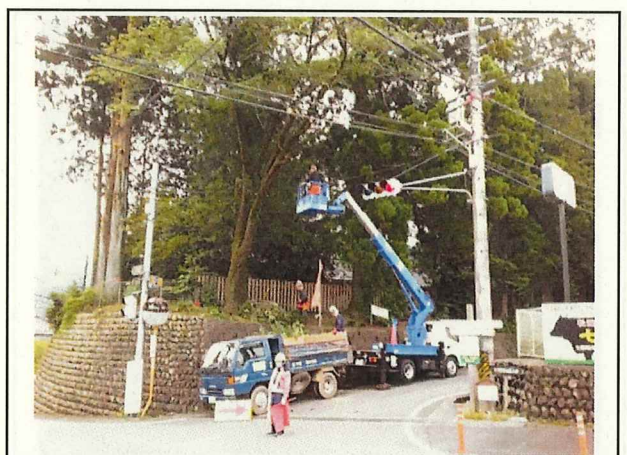
写真4 野原久保地区 生活道路作業中
