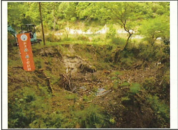
写真2 野原引瀬地区 作業中
