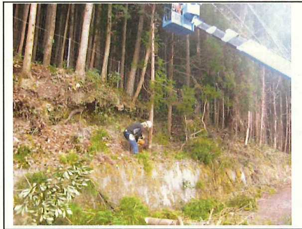
写真4 大台町清水地内危険木伐採【施工中】
