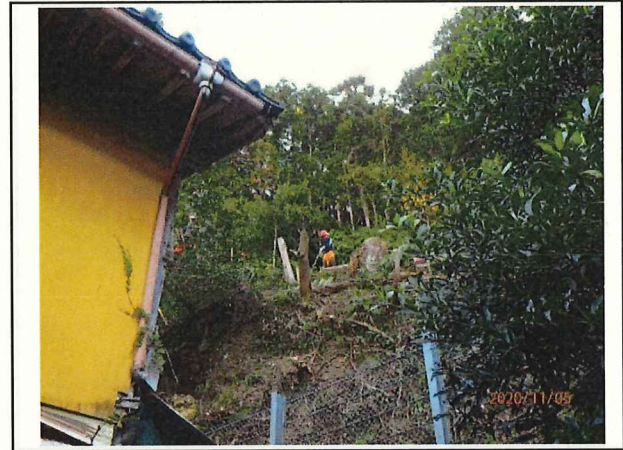
写真22 錦の場地区 人家裏作業中
