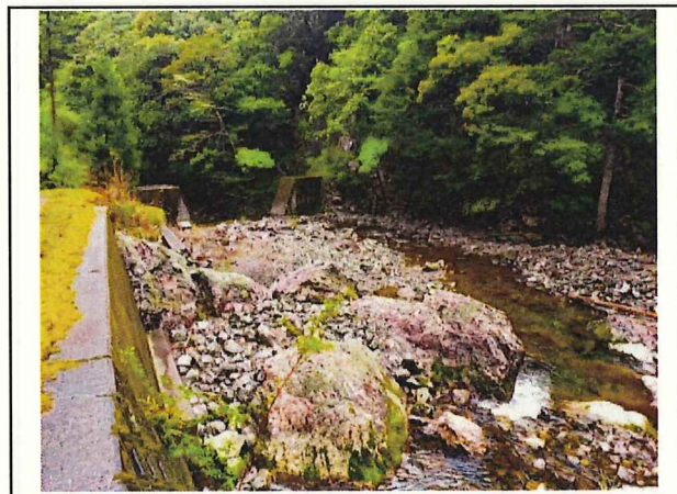
写真18 大内山池ノ谷地区 完成
