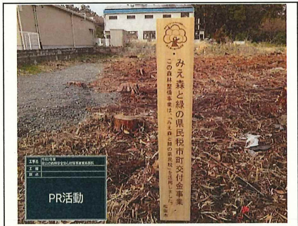
写真7 PR標柱設置状況
