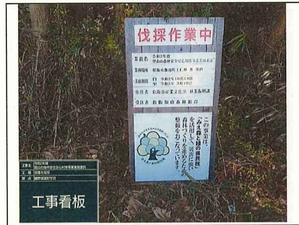
写真11 工事看板設置状況 (事業PR仕様)
