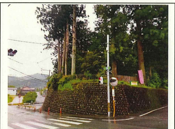
写真5 野原久保地区 生活道路完成
