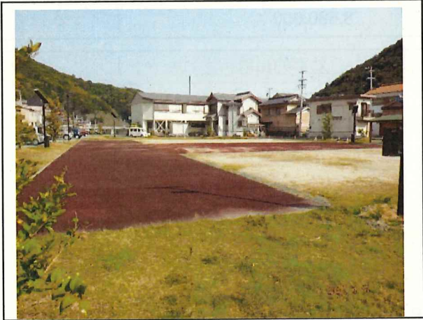
写真1 阿曾浦公園 ウッドチップ舗装 前
