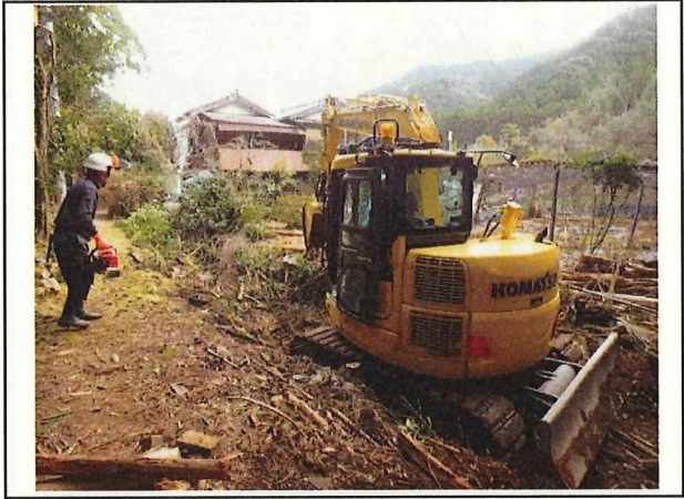
写真14 崎下崎地区 作業中
