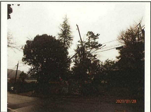
写真15 滝原頓登原地区 生活道路作業中
