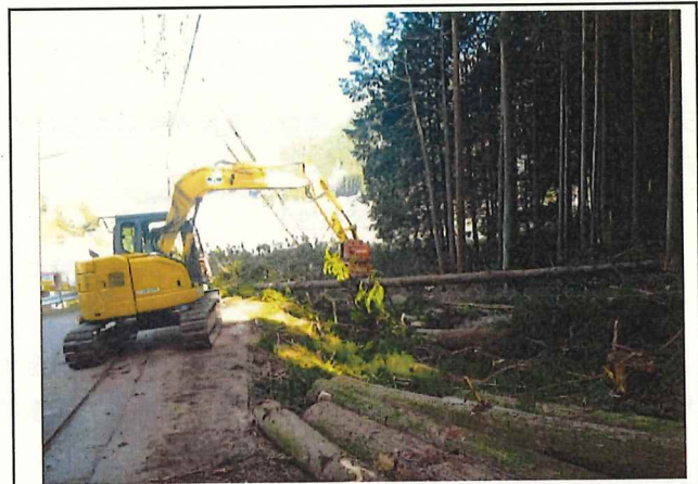
写真4 災害からライフラインを守る事前伐採事業 (美杉町八知地内 実施中)
