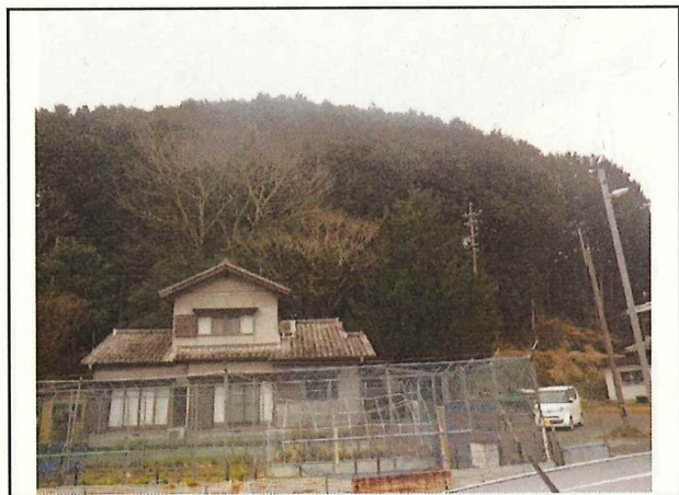
写真7 滝原河原地区 人家裏危険木着手前
