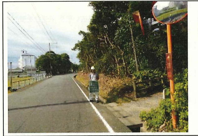
写真4 危険木伐採後
