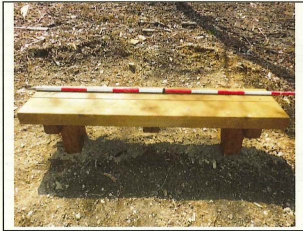
写真4 木製ベンチ設置状況
