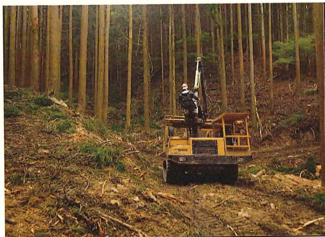
写真3 林地残材の積込状況（山土場）
