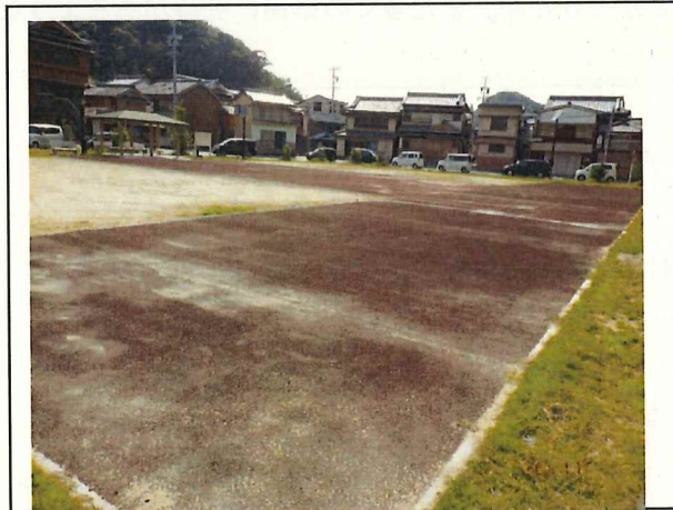
写真3 阿曾浦公園 ウッドチップ舗装 前
