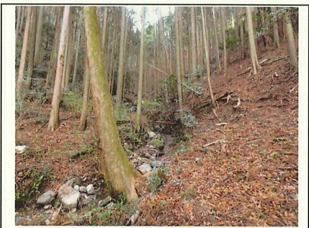
写真12 柏野柿ノ谷地区 完成
