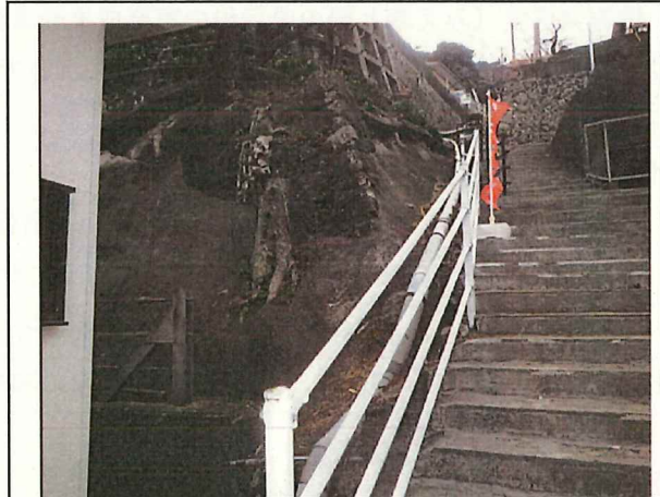
写真6 危険木伐採事業業務委託（神島地区）【施行後】
