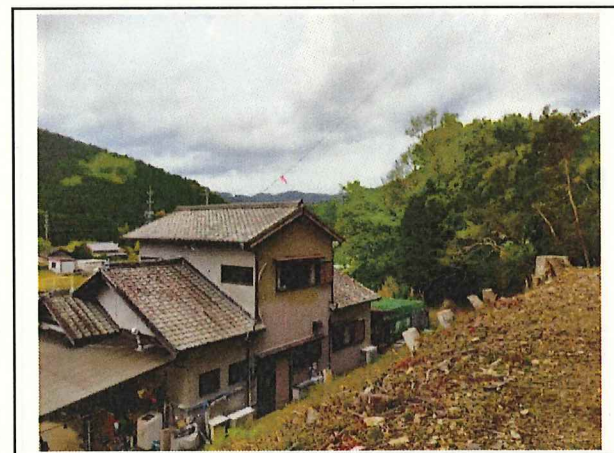
写真12 滝原河原地区 人家裏危険木完成
