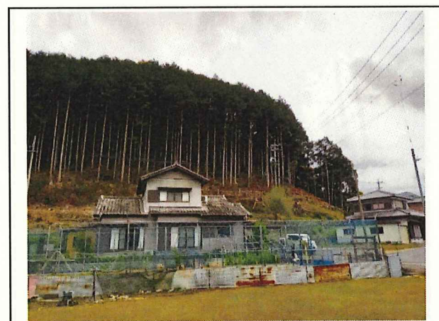
写真11 滝原河原地区 人家裏危険木完成
