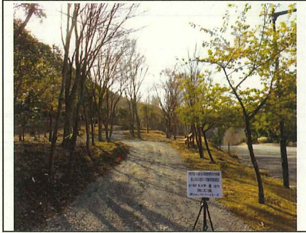
写真2 伐採、敷砂利舗装工【施工後】
