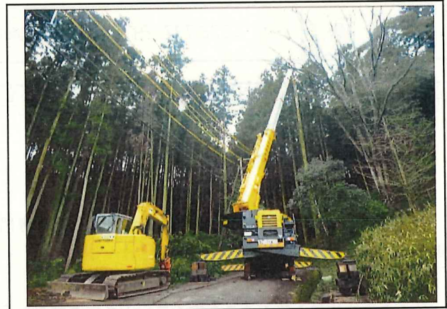
写真2 災害からライフラインを守る事前伐採事業 (美杉町八知地内 実施中)
