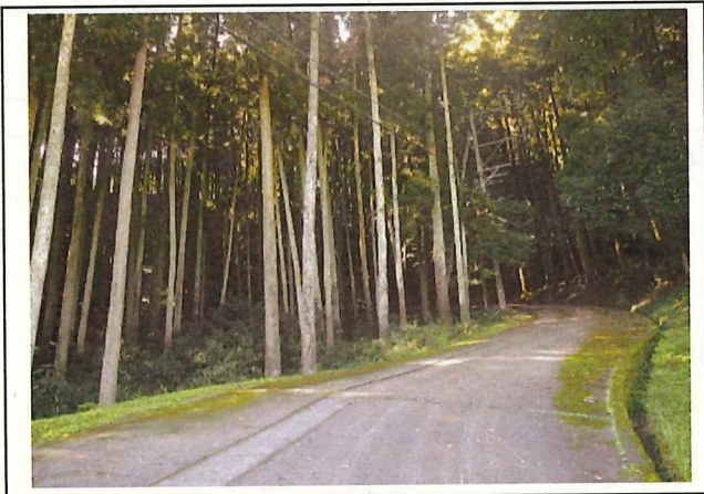
写真1 災害からライフラインを守る事前伐採事業 (美杉町八知地内 実施前)
