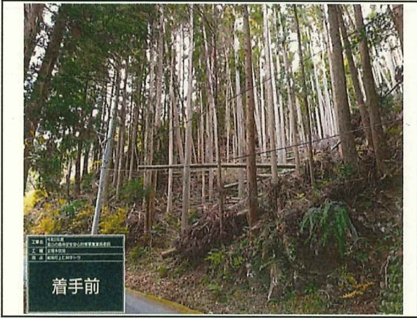
写真1 森林整備(着手前)松阪市飯南町上仁柿地内 地域の幹線道路際で倒木の恐れがあり、孤立集 落を招く懸念がある。
