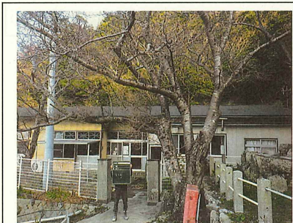
写真11 危険木伐採事業業務委託（神島地区）【施行前】
