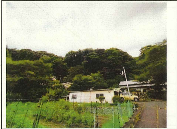
写真25 大内山向駒地区 人家裏着手前
