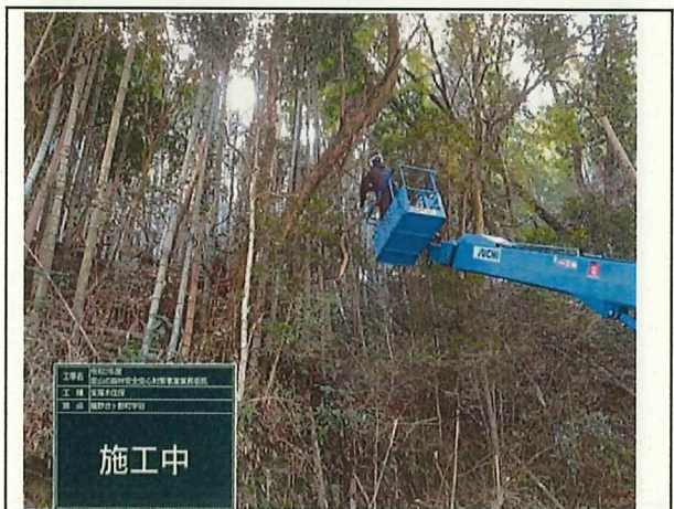
写真6 森林整備(作業状況) 17m級高所作業車使用
