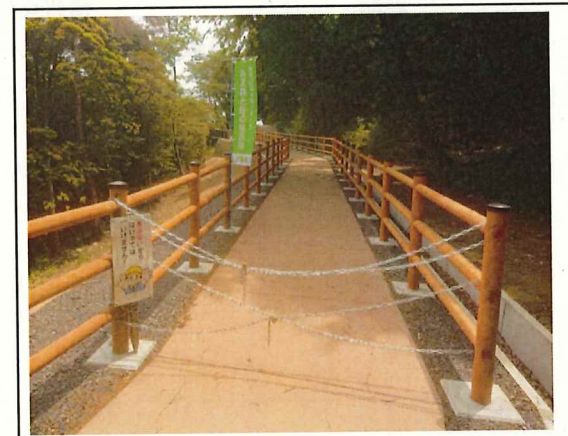
写真6 施工後③ 一部運用開始
