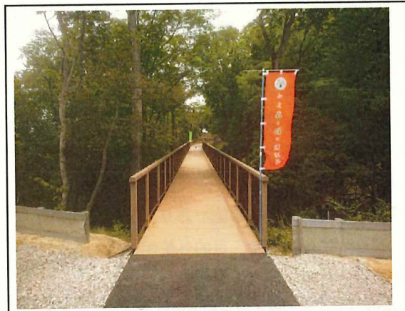
写真4 施工後① 一部運用開始
