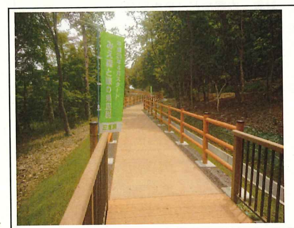
写真5 施工後② 一部運用開始
