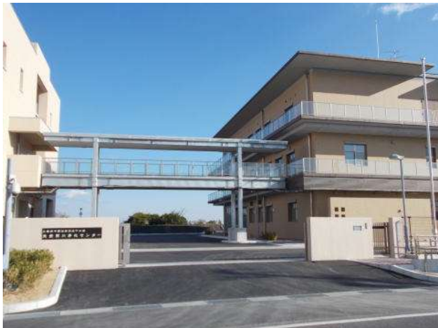
志登茂川浄化センター
