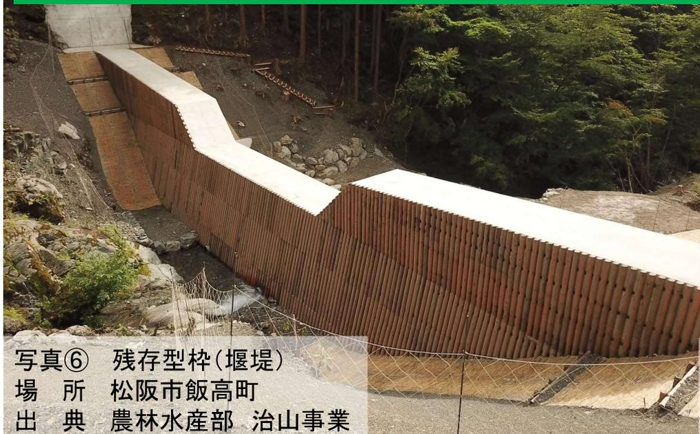
写真⑥ 残存型柵(堰堤)
