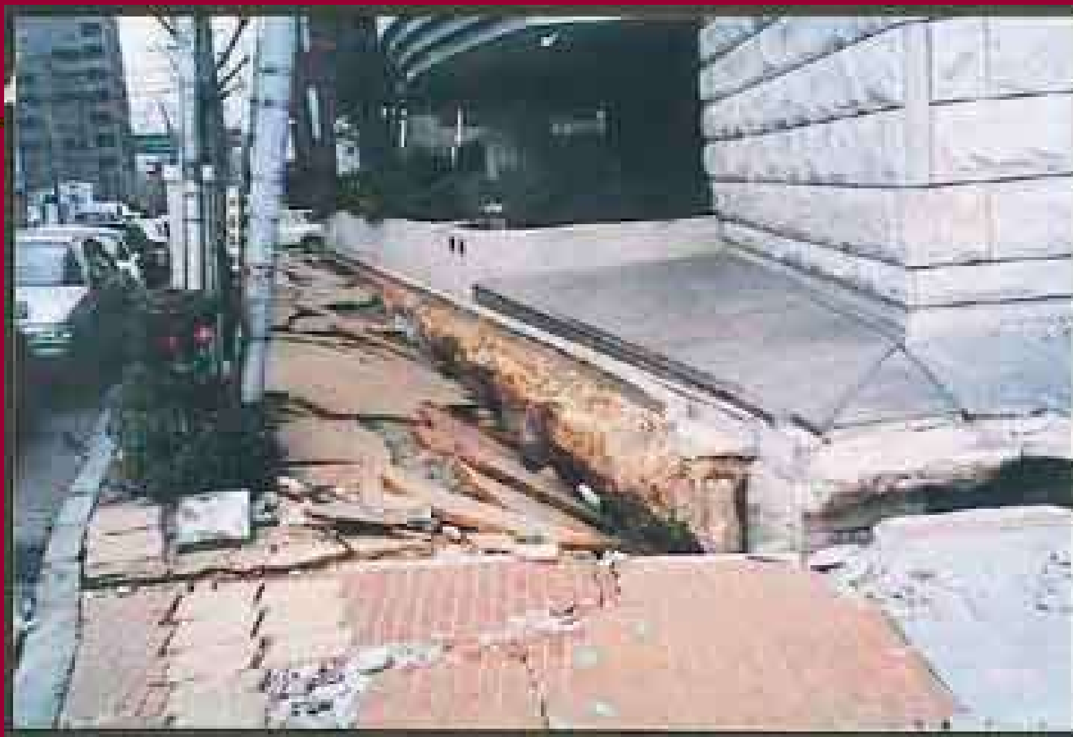
写真一8 地盤の液状化のため沈下した建築物周辺(P42)
