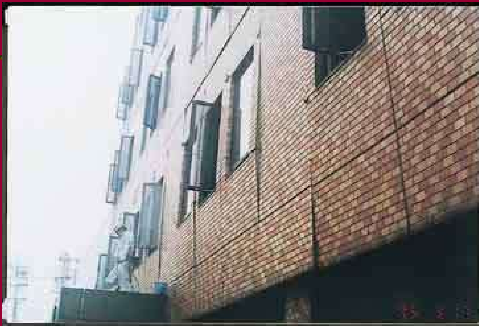
写真ー1 純ラーメン5階事務所ビルのPCカーテンウォールの損傷(P35)
