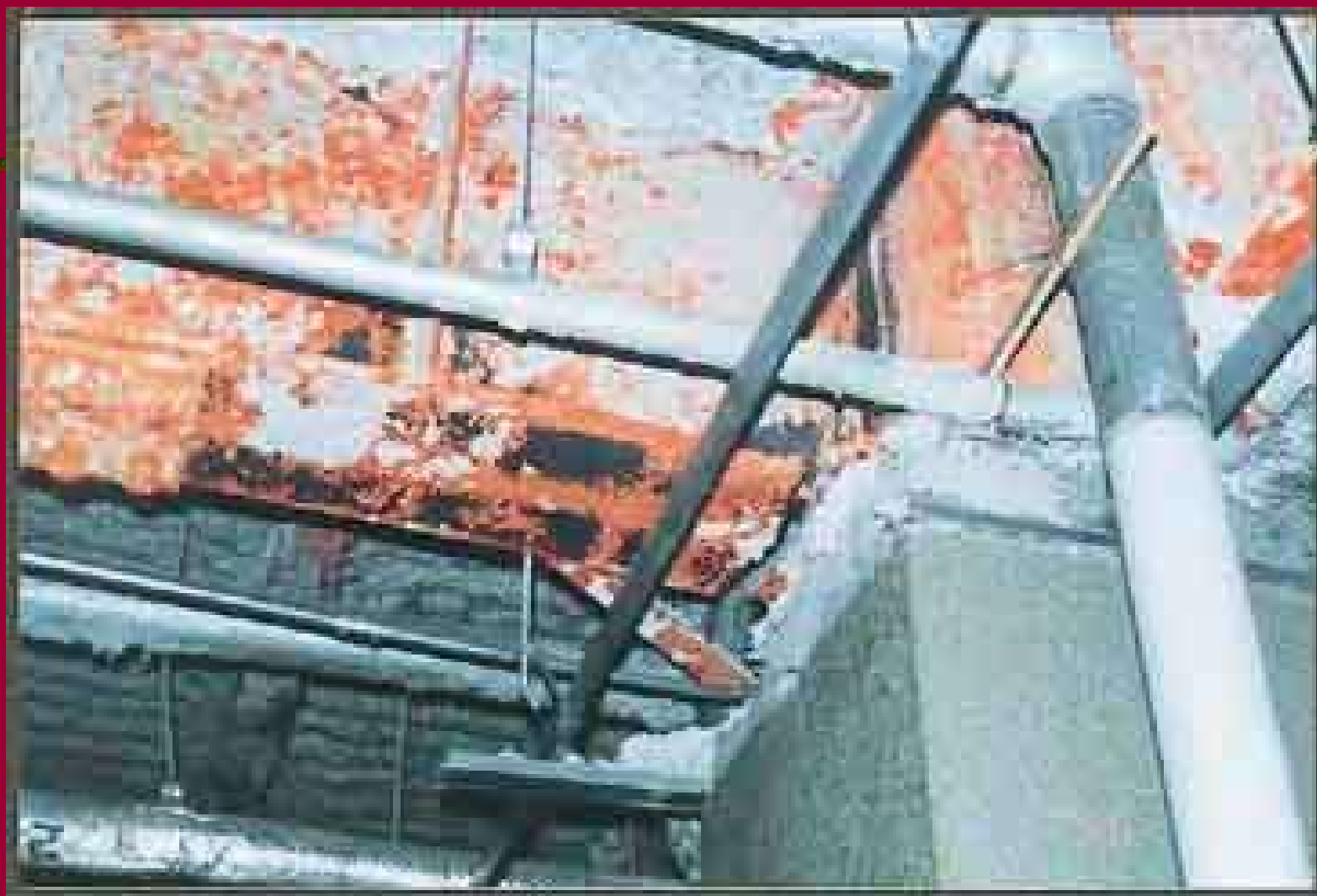
写真－2 同上建築物内部の梁端部の降伏及び破断(P36)
