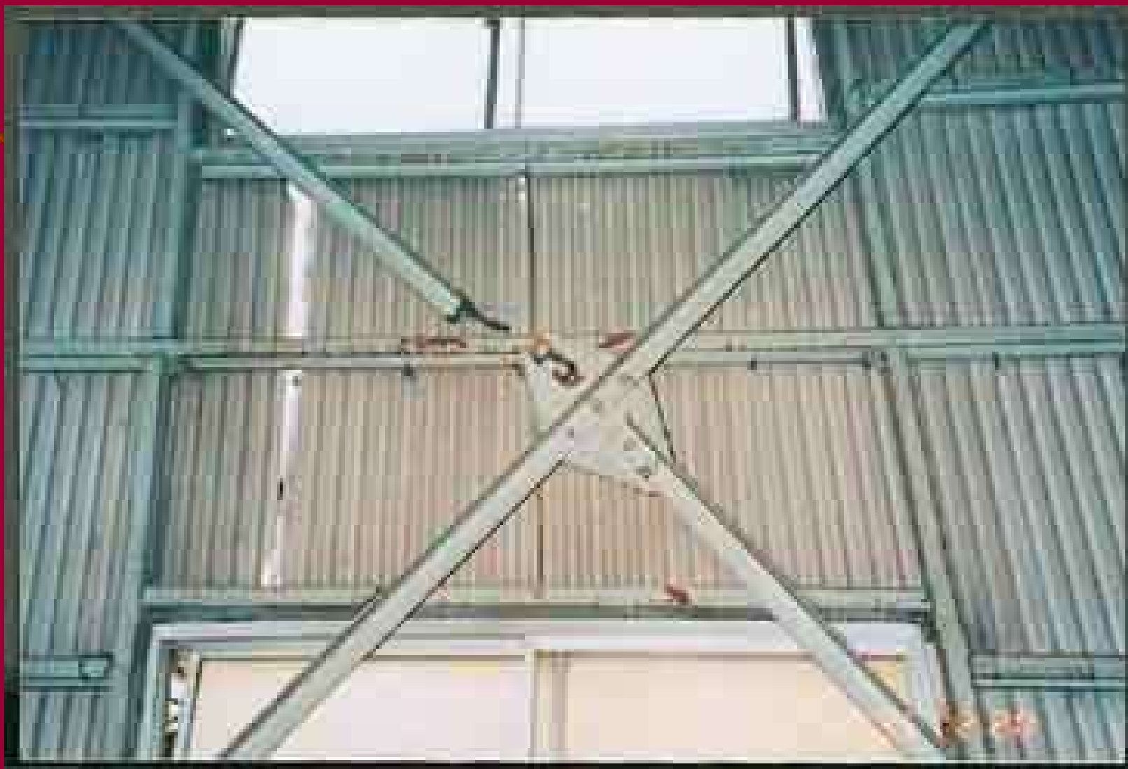
写真ー16 アングル筋違の破断(P50)
