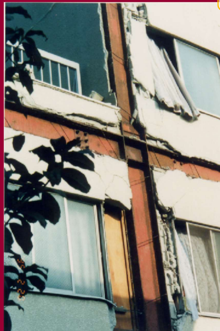
写真-23 落下危険物Cランクの例(P23)
