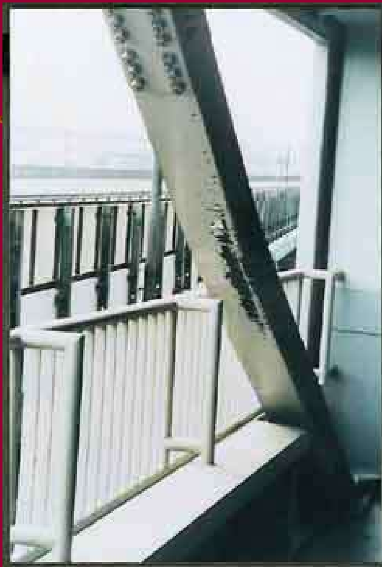
写真－17 H形鋼筋違の座屈(P50)
