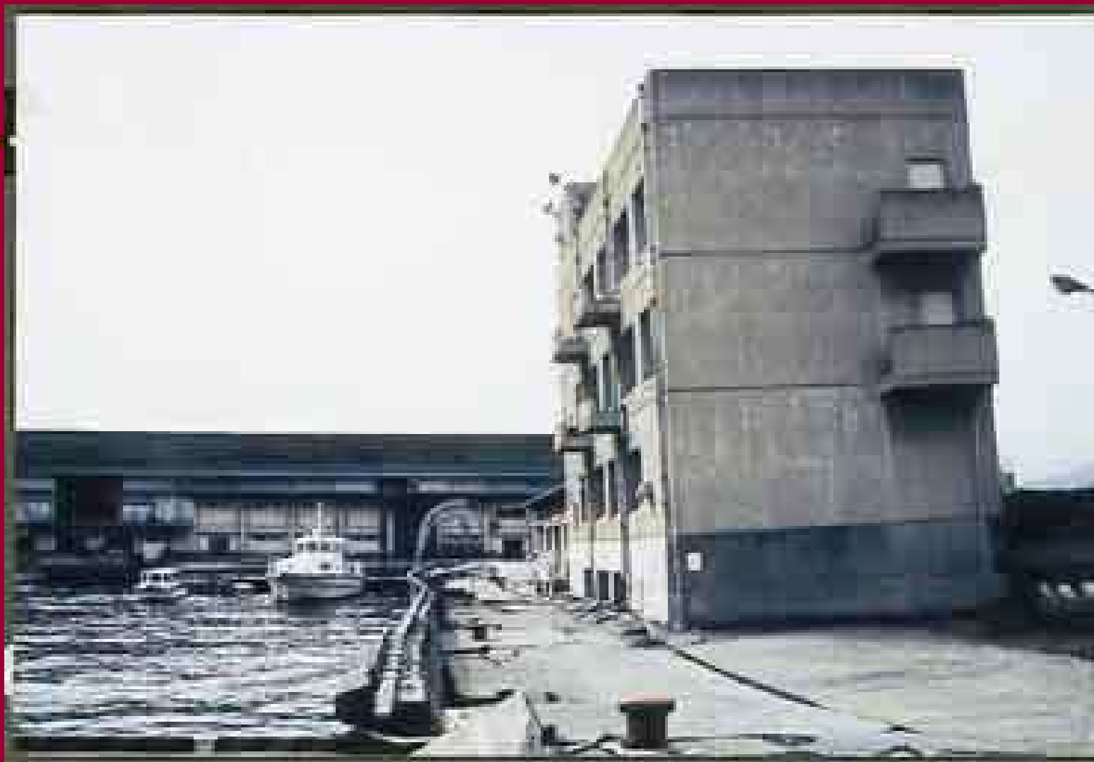
写真－9 地盤の側方流動(護岸の移動)のため傾斜した建築物(P43)
