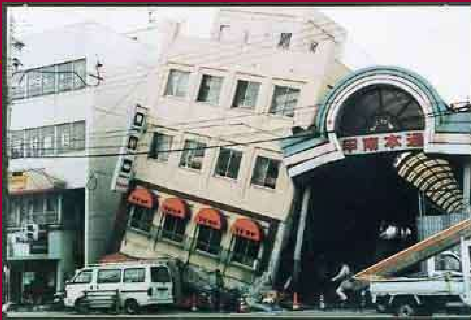
写真ー7 アーケードへの倒壊の危険性のある建築物(P41)
