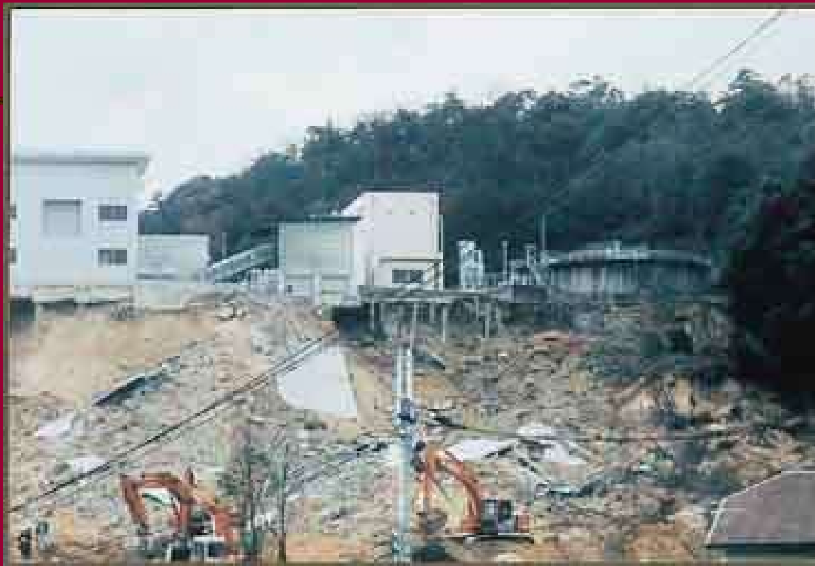
写真一6 建築物の敷地の崩壊危険(P41)
