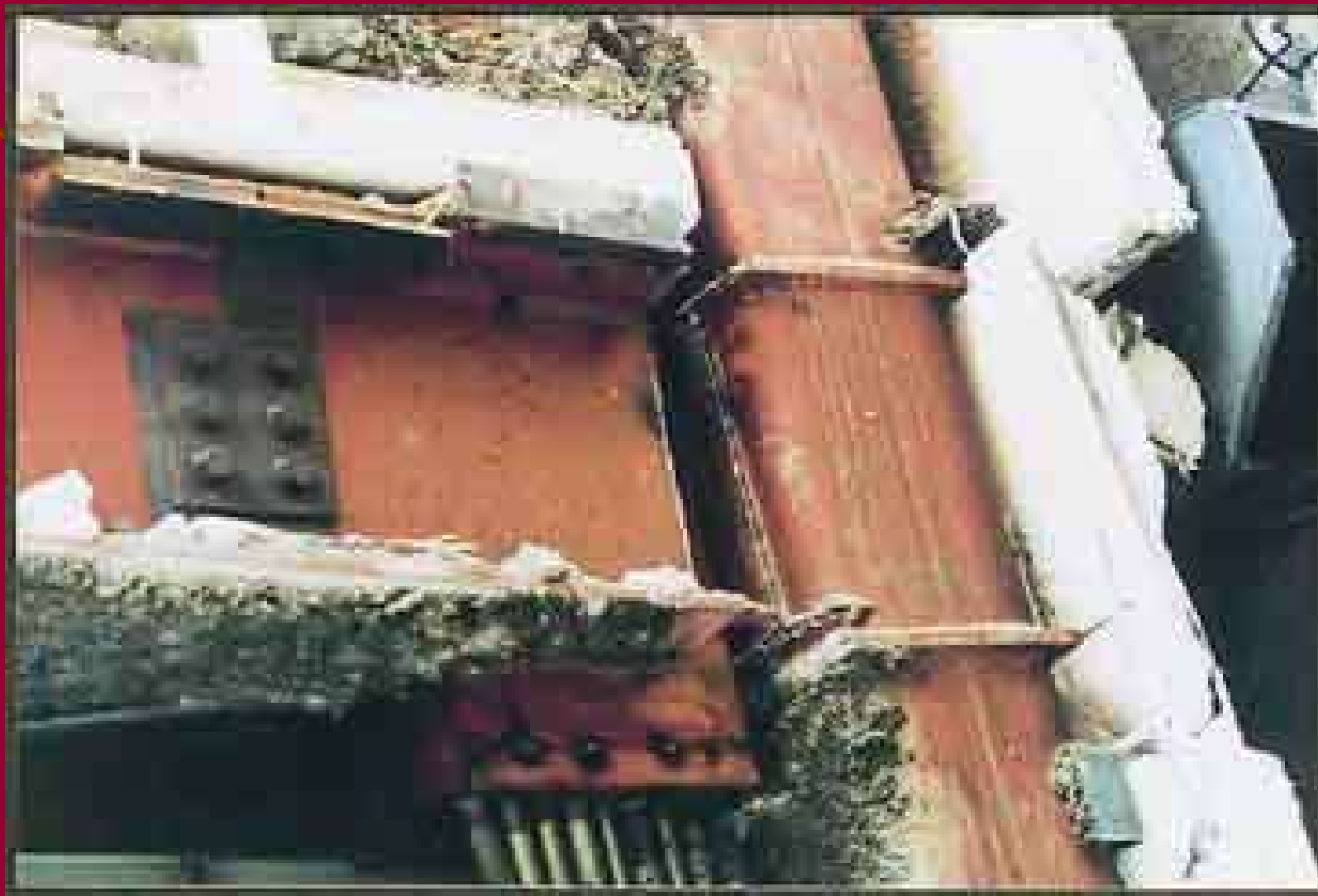
写真一18 梁端部溶接部の破断(P51)
