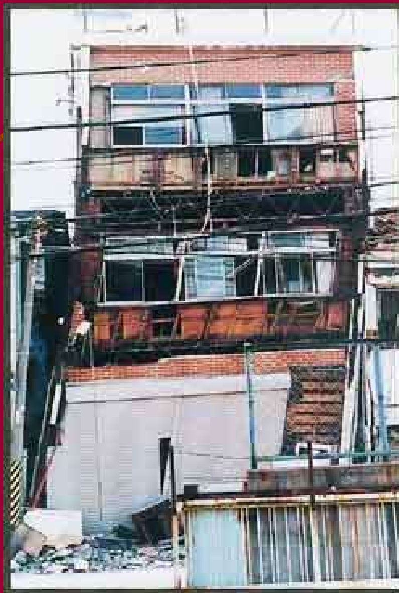
写真－12 1階及び2階にのみ傾斜を生じた建築物(P46)
