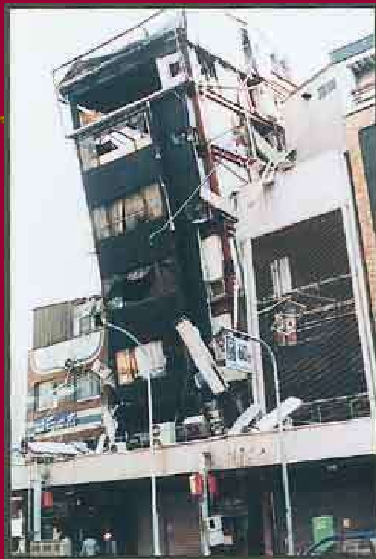
写真一11 傾斜した建築物(P46)
