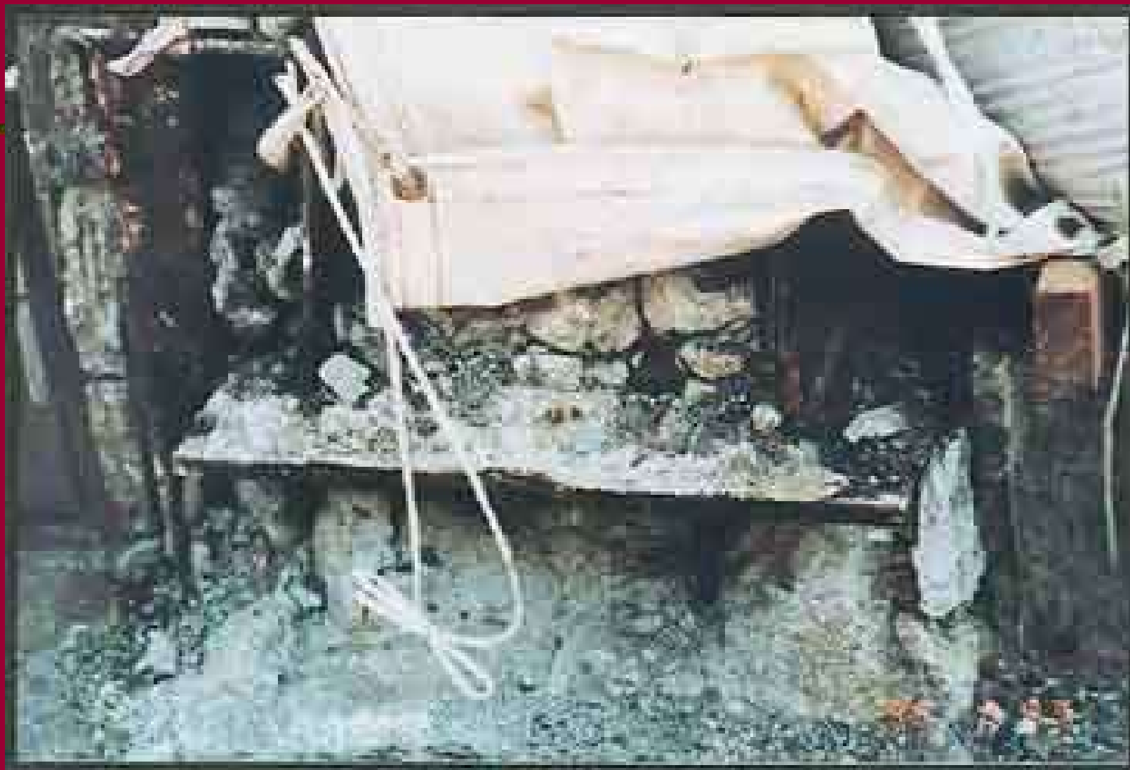
写真ー21 軸力支持能力を失った柱脚ベースプレート下部コンクリート(P54)
