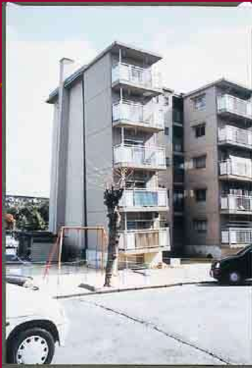
写真一10 不同沈下のため傾斜した集合住宅(P43)
