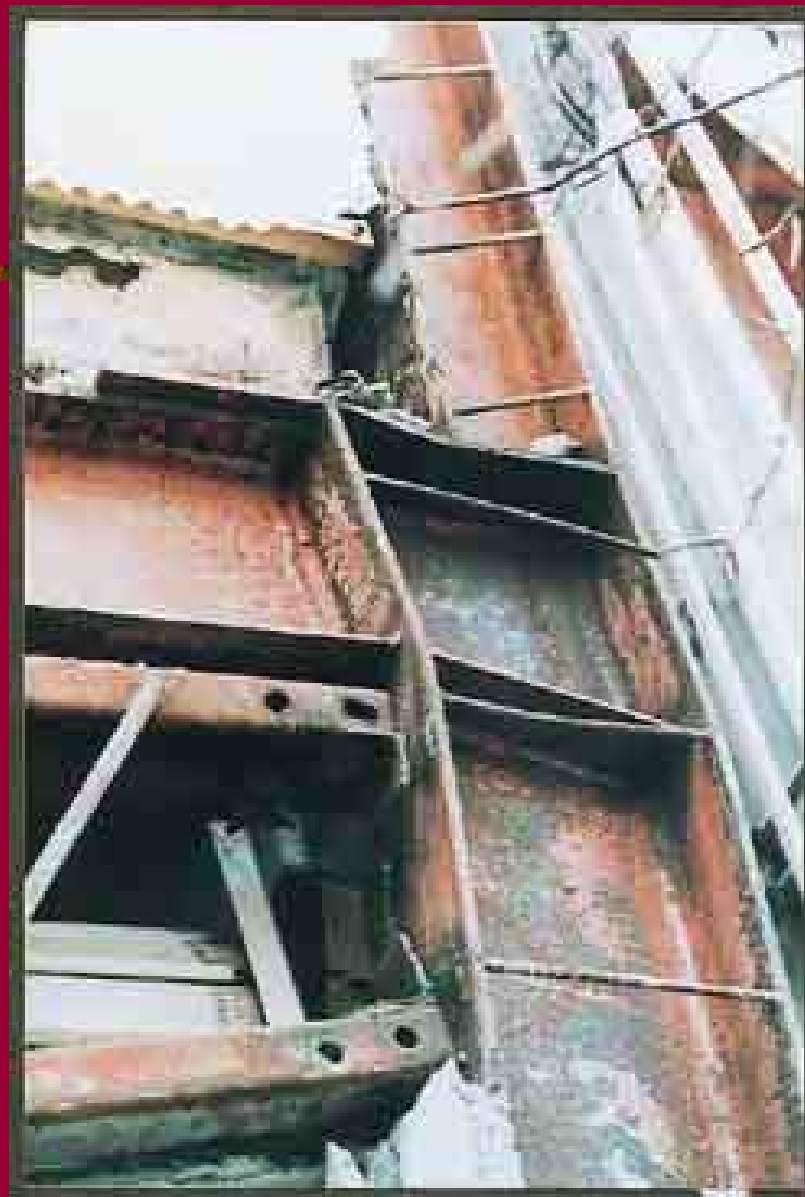
写真－14 著しく腐食した柱材の局部座屈(P48)
