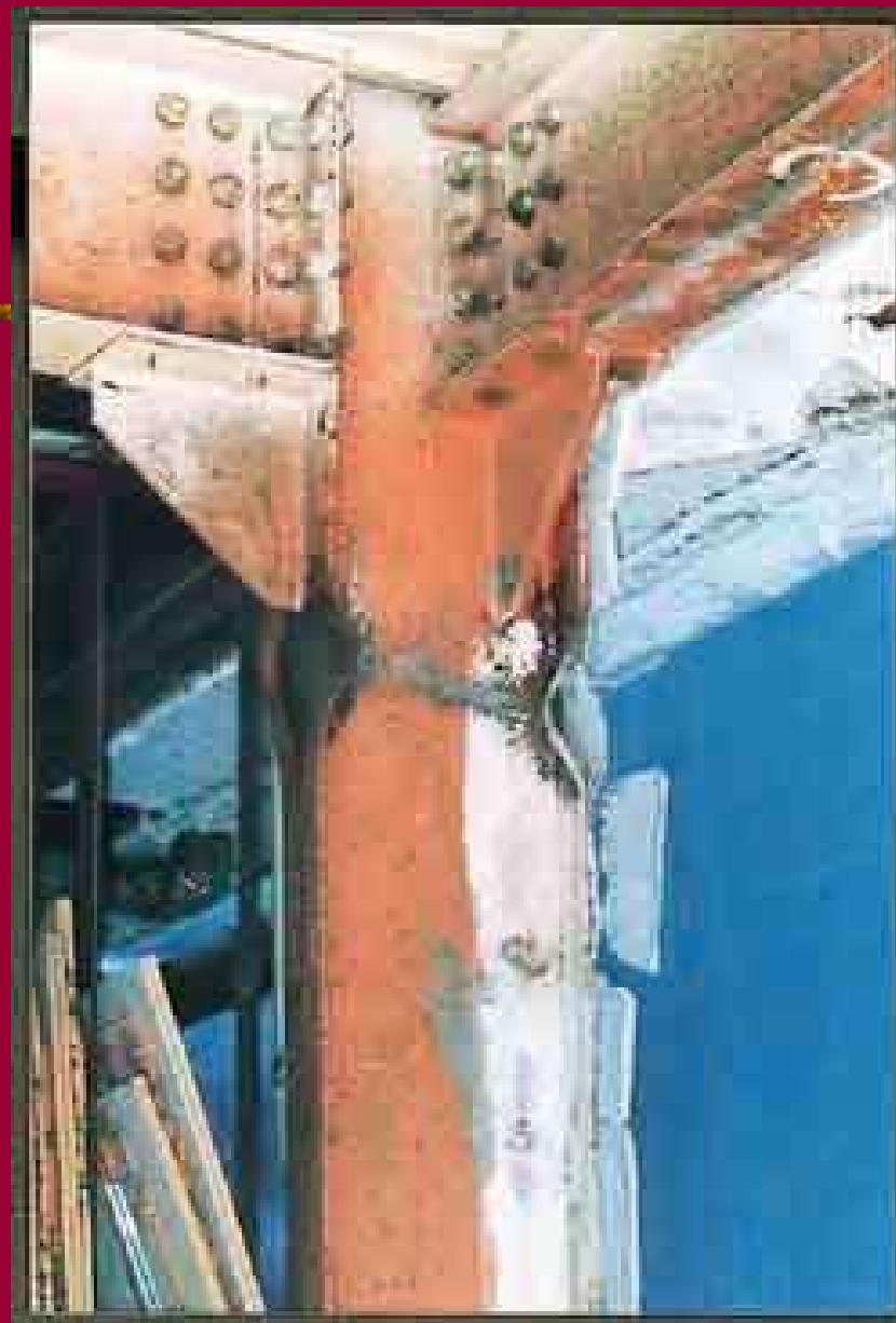
写真一13 局部座屈を生じた柱(P48)
