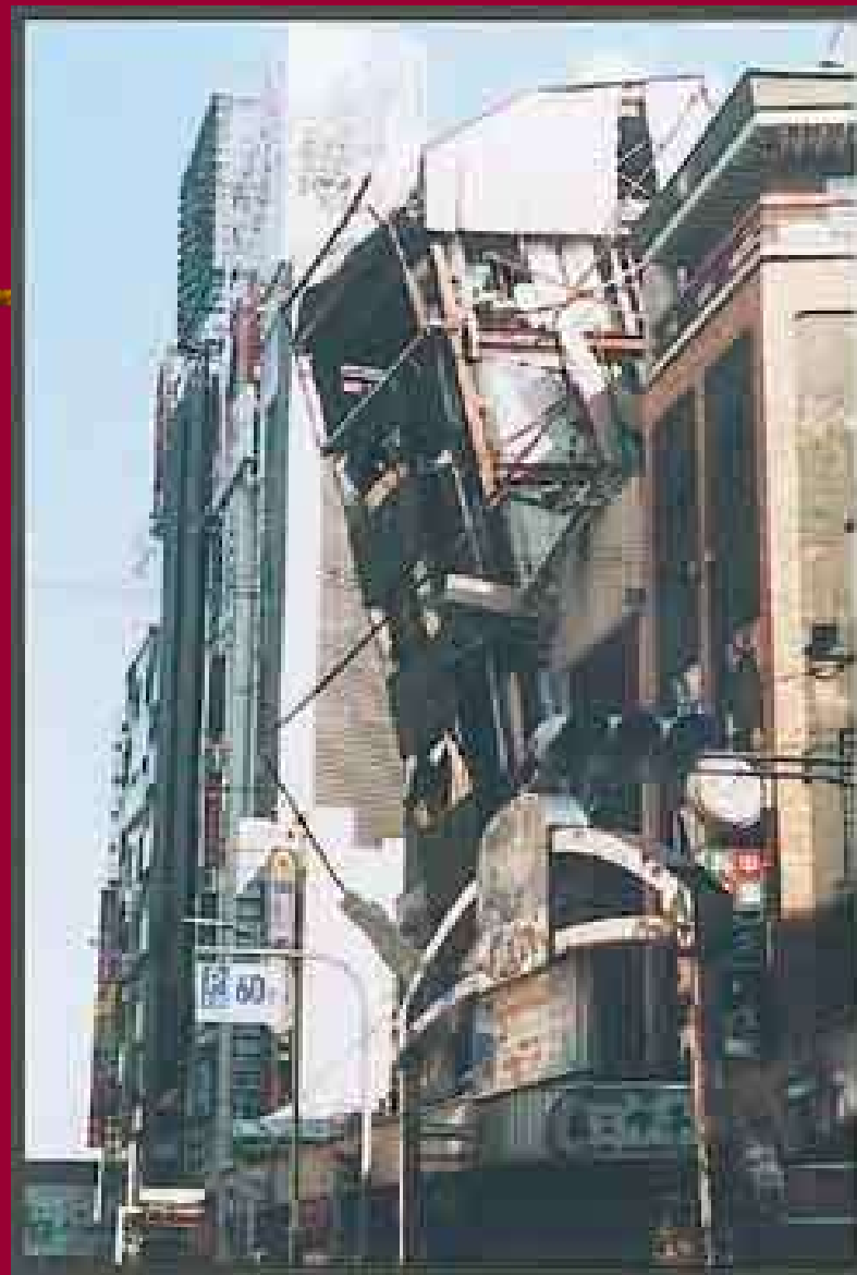
写真一4 著しく傾斜した建築物(P40)
