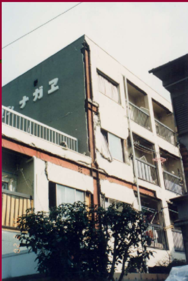
写真-23 落下危険物Cランクの例(P23)
