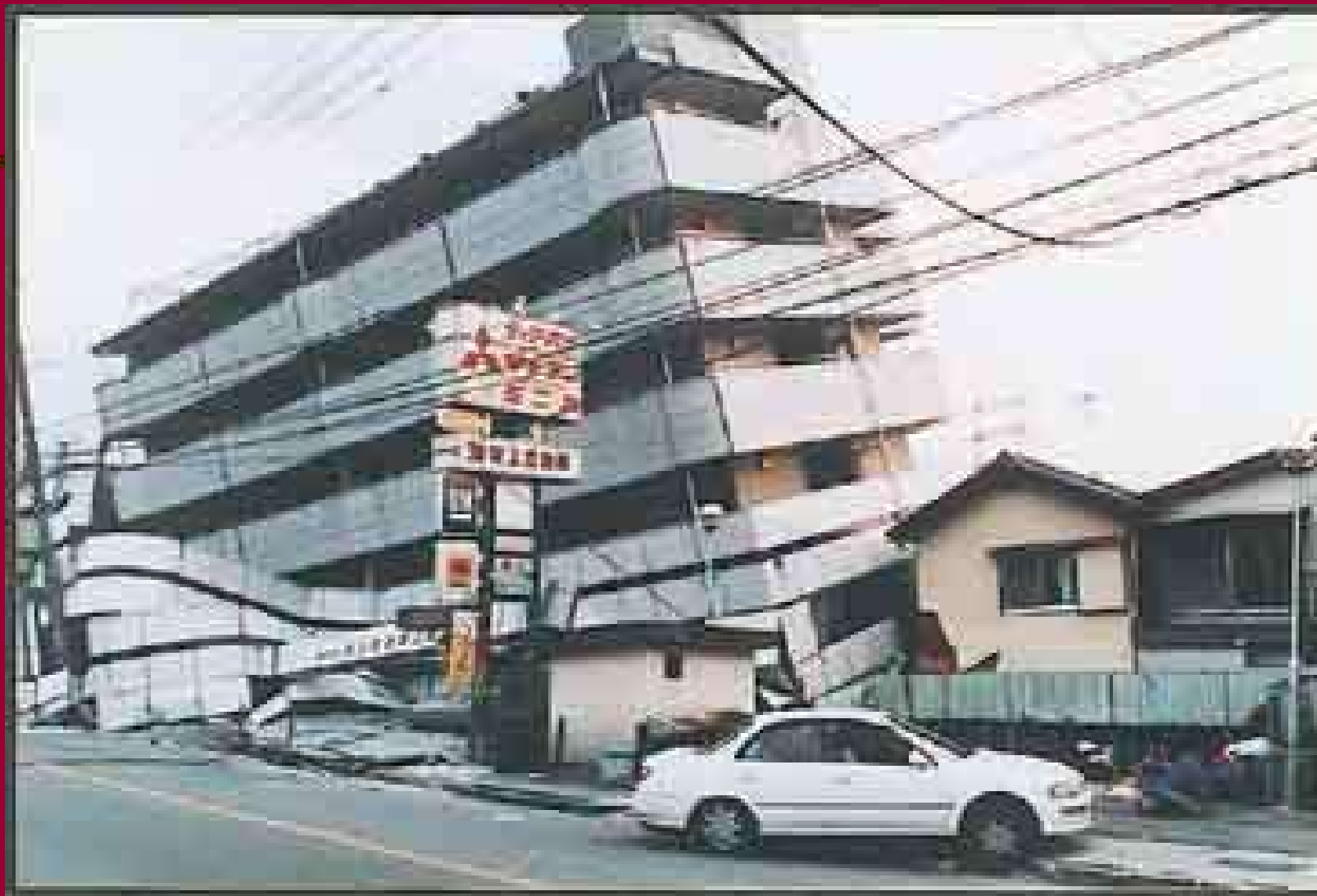
写真－3 低層階で落階した建築物(P39)
