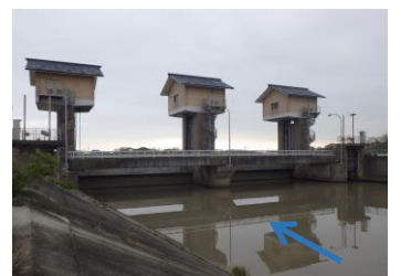
二級河川笹笛川水門耐震対策（明和町）
