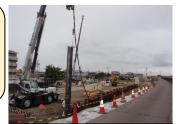
二級河川堀切川堤防耐震対策（鈴鹿市）
