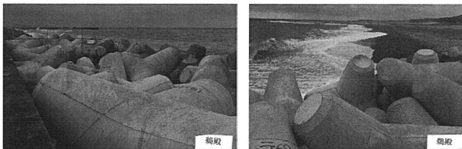
鵜殿港海岸 L=59.0m 海岸コンクリート(消波)ブロック製作、据付工
