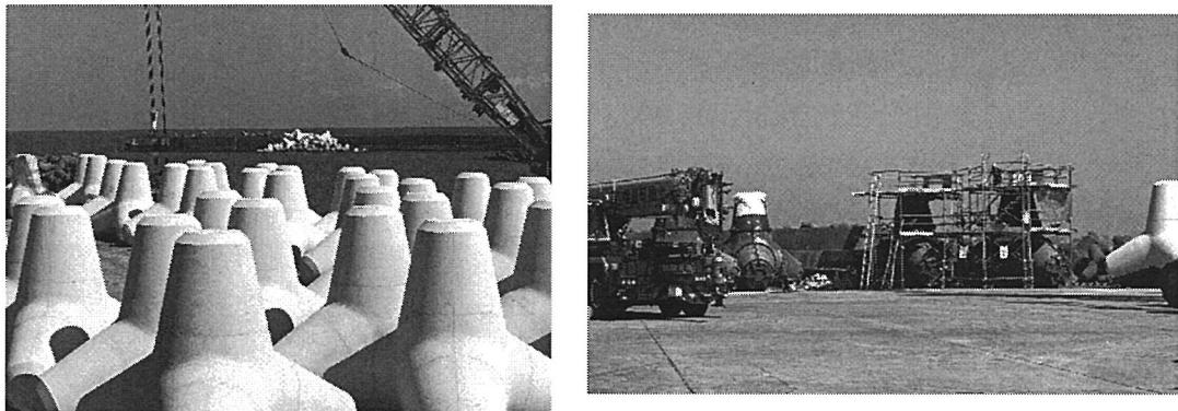
消波ブロックは防波堤の外側に設置されている
