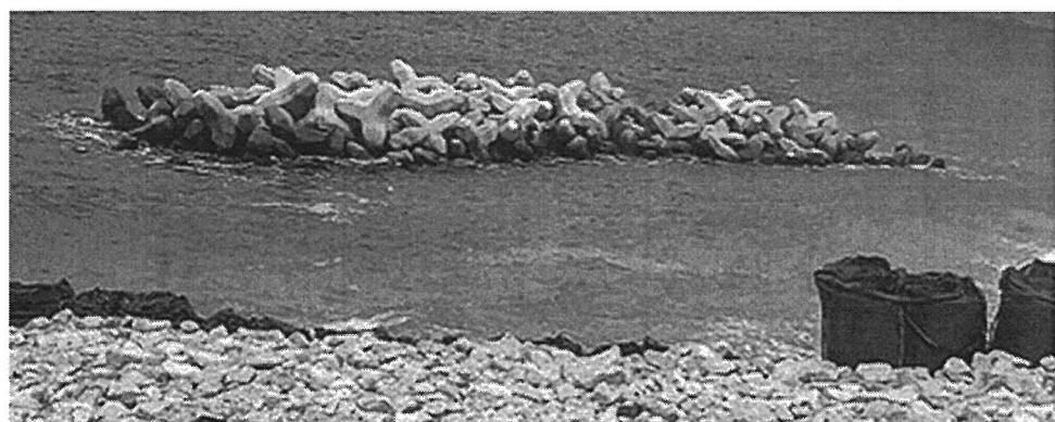
離岸堤（奥の海岸の中の施設）消波工（手前の敷き詰めたブロック）
