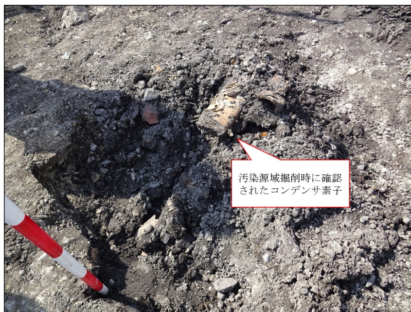
図 -7 支障除去対策事業において新たに出土したコンデンサ素子
