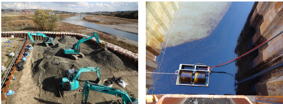
図 -7 低水護岸部における釜場掘削（左） スキマーによる油回収（右）
