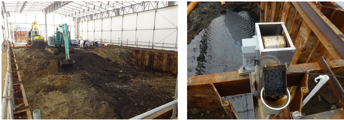
図 -6 汚染源域における釜場掘削（左） スキマーによる油回収（右）
