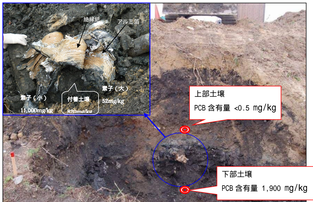
図 -6 掘削調査状況および確認された PCB 含有コンデンサ素子 (左上)
