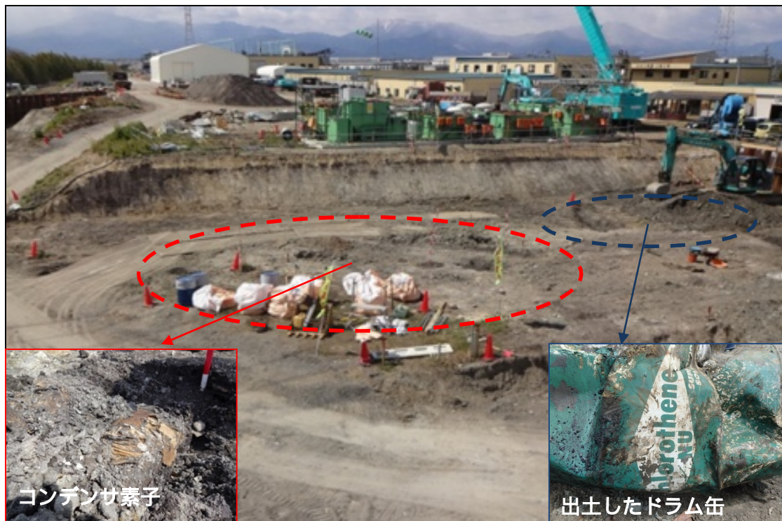
図 -8 汚染源域掘削時の状況および確認された廃棄物
