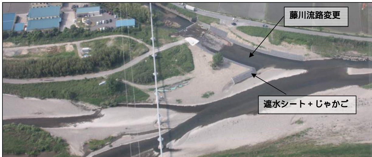
図 -25 県による瀬替えの状況
