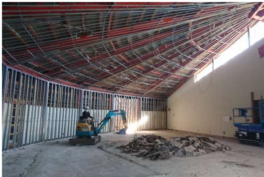
内装解体工事（9月）
