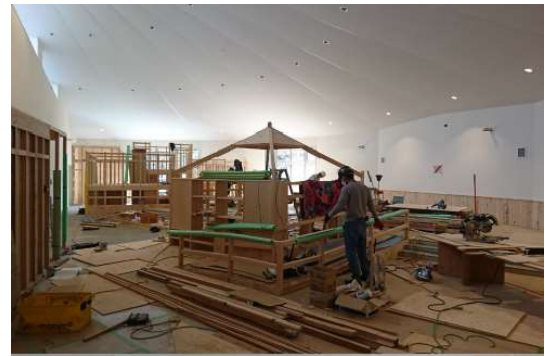
大型木製遊具建込み（11月）
