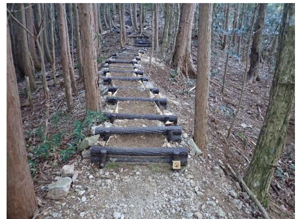
自然観察ツアー&ボランティア整備 歩道補修（整備後）
