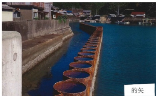
海岸高潮対策工事 L=48.5m
