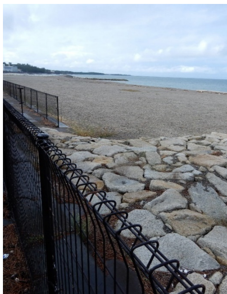
R 2～R 3 養浜工 L=195m V=3,910 m 3
