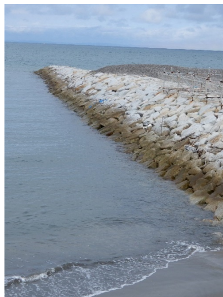
R 2～R 3 養浜工 L=195m V=3,910 m 3
