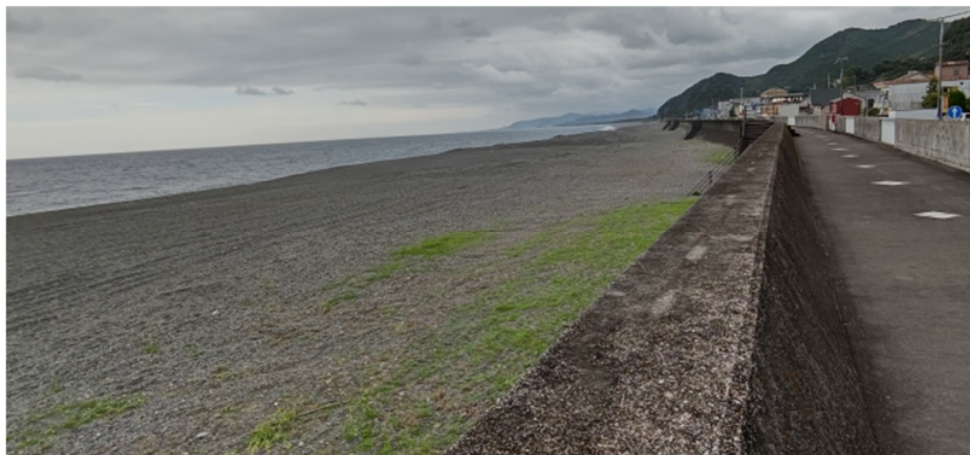
海と堤防の間の砂浜が養浜で人工的に形成された浜 熊野海岸
