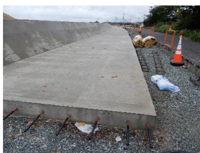
施工延長 L = 180m
