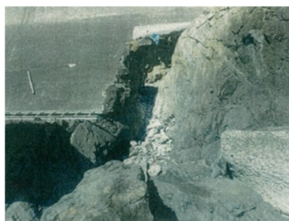
安乗第4工区施工前
