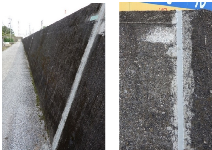
昭和 38 年 11 月に施工された四日市市霞ヶ浦地区海岸の 老朽化対策のため、防潮堤の コンクリートの隙間をコーキング材で補修している
