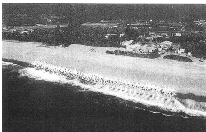
井田地区海岸 養浜工 その2 提供：熊野建設事務所
