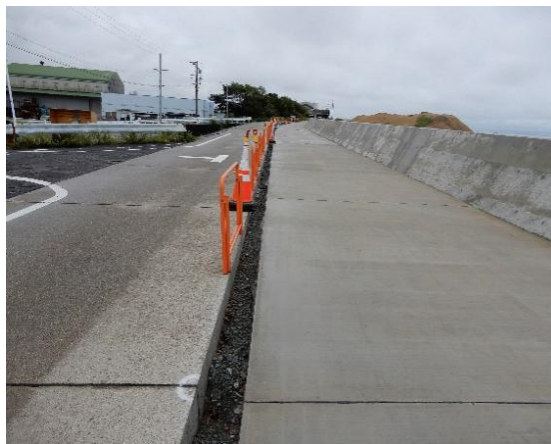
施工延長 L = 123.7m
