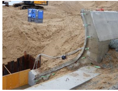
既存の堤防の海側へ築造
