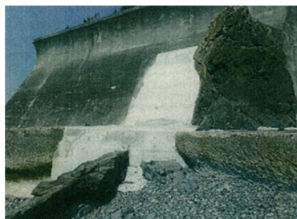
安乗第4工区施工後
