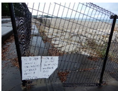
工区の表示（施行番号 50205665 と同所）
