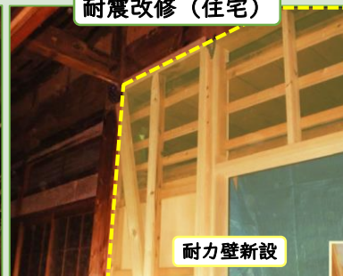
耐震改修 (住宅)
