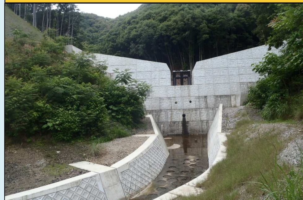
完成（砂防えん堤）
