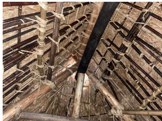
屋根裏の小屋組
