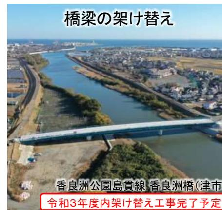
緊急輸送道路において、被災時に通行止めが長期化する渡河部の橋梁流失の災害リスクに対し、橋梁の架け替えを推進
