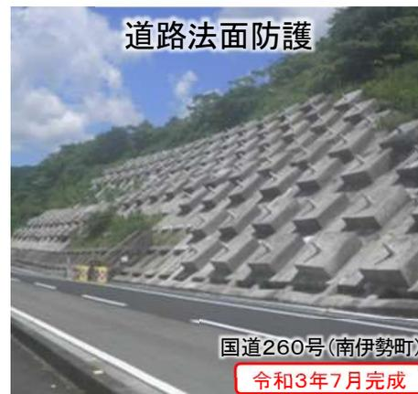
緊急輸送道路において、豪雨による土砂災害等の発生を防止するため、土砂災害の危険性がある箇所に対する道路法面・盛土対策を推進
