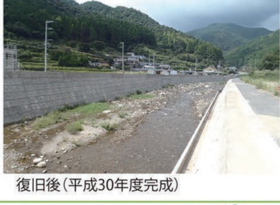
復旧後(平成30年度完成)
