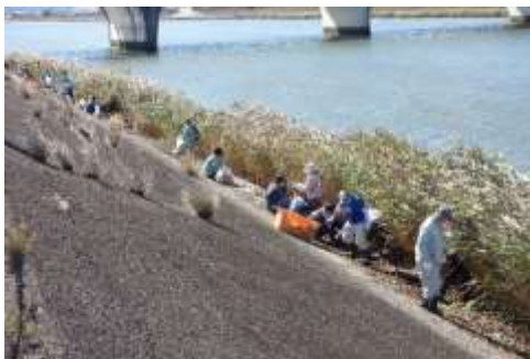
R3. 10. 23_新川・庄内川中堤 (愛知県)
